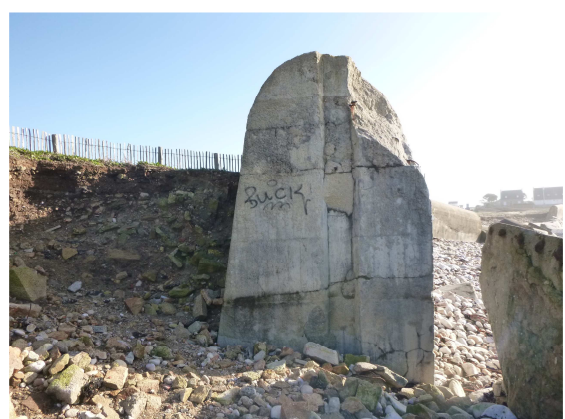
Mur en soutènement sur ~3m
