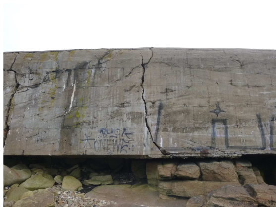
Fracture d'ouverture pluricentimétriques sans rejet horizontal en pied mais à décalage vertical de 4cm significatif d'un affaissement du bloc 2018-M4-B-2-0 fortement sous-cavé
