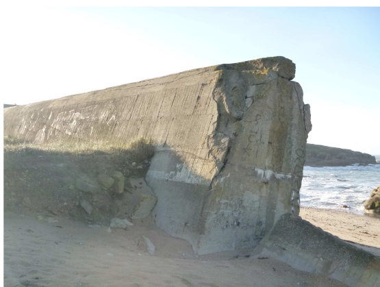
Mur en soutènement sur ~1.6m
