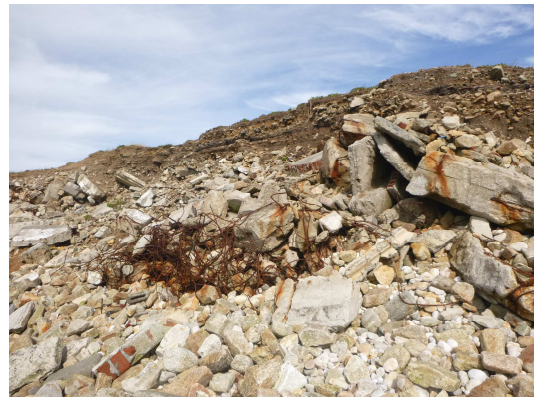
Ferrailage dans les débris à l'arrière du bloc 2018-M1-B-15-0
