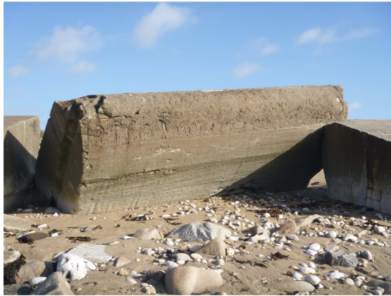
Bloc 2018-M2-B-4-0 basculé vers la grève et montrant une section transversale globalement complète
