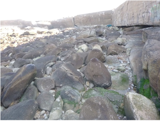
affleurement de leucogranite à gros grain au Sud du site (P405 à P420) recouvert d'un manteau de blocs de volume individuel moyen allant de 0.2 \text{ m}^3 à 0.6 \text{ m}^3
