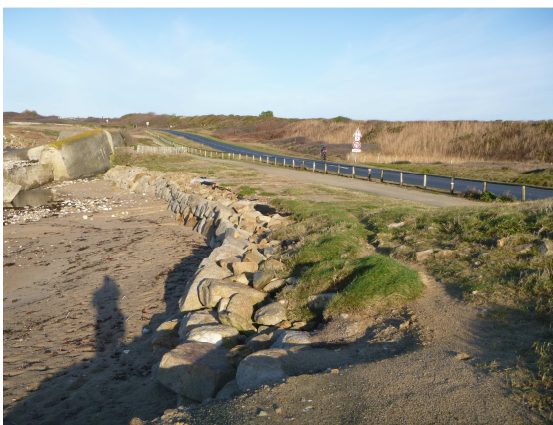
perré en enrochements (~P220 à ~P280)
