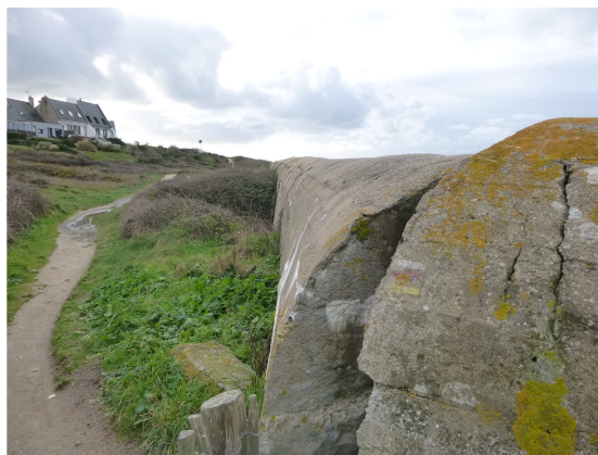
de ~P280 à ~P310, couronnement de mur distant de ~0 à ~10m du bord du sentier
