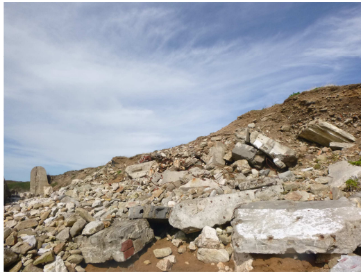
Ferrailage dans les débris à l'arrière du bloc 2018-M1-B-14-0
