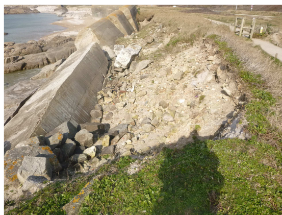
de ~P370 à ~P380, crête de micro-falaise et bord de piste cyclable éloignés d'une distance allant de ~2.3 à ~3.3m
