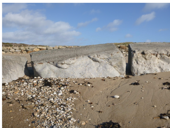
Ablation du couronnement du bloc 2018-M2-B-9-0
