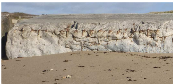
Couronnement du bloc 9 du mur M2 avec treillis d'armatures métalliques avec maillage de 30 cm de côté
