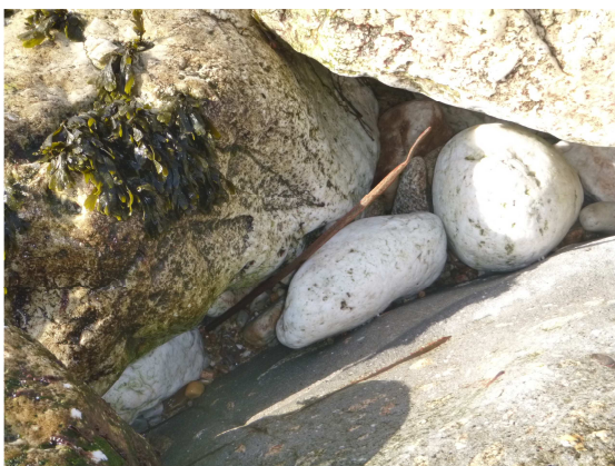
Sur l'estran, armatures de 50cm à proximité du bloc 2018-M1-B-13-3
