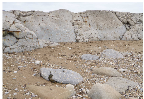
démantèlement du couronnement du bloc 2018-M2-B-10-0 en petits blocs
