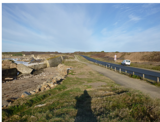
de ~P220 à ~P270, crête d'enrochements distante de ~5.5m du bord de piste cyclable et de ~9m du bord de chaussée
