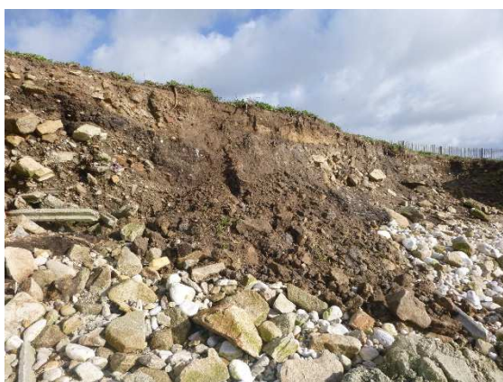
Glissement de terrain récent de ~7m de long et ~1.5m d'épaisseur à l'arrière du 17 ème bloc avec langue glissée de Photo du 01 02 2018
