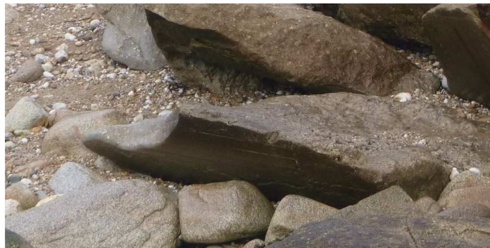
Bloc 2018-M3-B-4-8 d'un volume de \sim 0.7\text{m}^3 et affecté par une fissure médiane transverse
