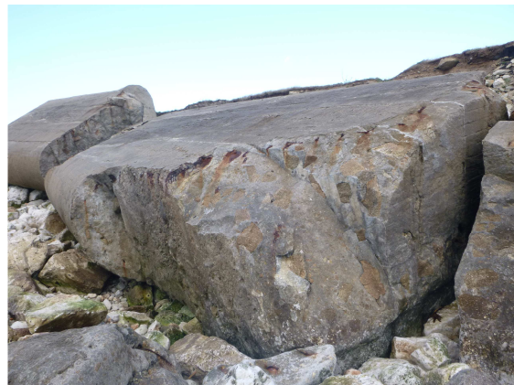
Bloc 2018-M1-B-12-0 d'une longueur de 12.2m et d'un volume de \sim 110\text{m}^3
