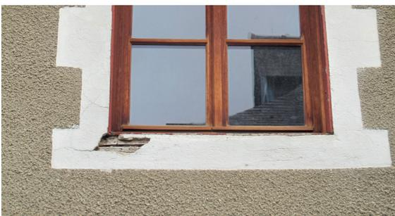
Eclats d'enduit au niveau des appuis de fenêtres de l'étage
