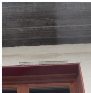
Enduit décollé au niveau du linteau de fenêtre de l'étage
