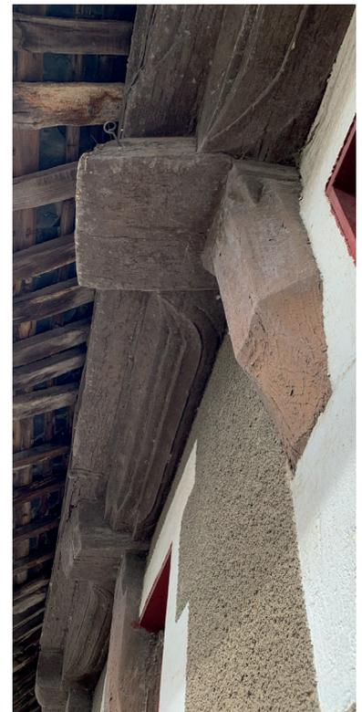
*Pigeâtre sous appui de poutre en console du plancher des combles*
