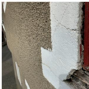
Détail d'éclat d'enduit laissant apparaître le pan de bois
