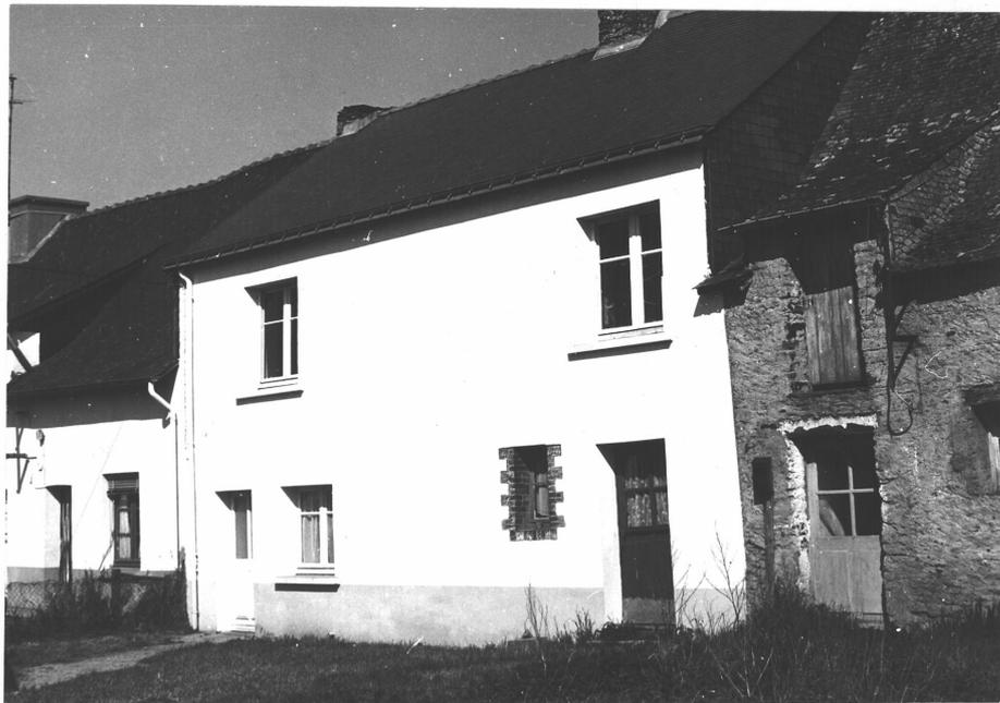
27/33 - Elévation Sud de l'alignement Nord-Sud. Parfait exemple de mauvais remaniement d'une maison ancienne : volume augmenté par le rehaussement du mur, ouvertures agrandies, crépi agressif.
