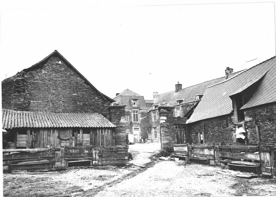
100/1 A - La disposition actuelle en cour fermée date du XVIII<sup>e</sup> siècle au moment de la construction des pavillons d'angle coiffés de hauts toits "à la Mansart" et des communs (dont les ouvertures ont été reprises au XIX<sup>e</sup> siècle), construits à l'équerre d'un corps de logis antérieur: ces importantes modifications anciennes marquent le désir de moderniser et de rendre plus imposant encore un édifice de qualité.
