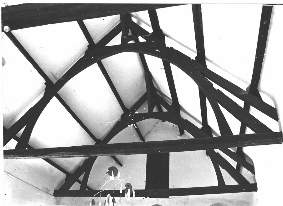
15/2 - Charpente apparente composée de trois fermes ; au fond contre le mur Ouest, les trois petites voûtes d'arêtes plâtrées reposent sur deux colonnes en bois : il s'agit peut être des vestiges d'une ancienne tribune.
