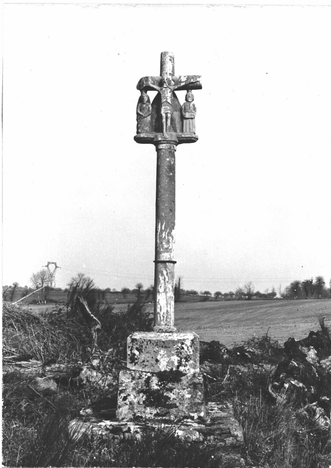
50/23 - Vue générale Ouest.
