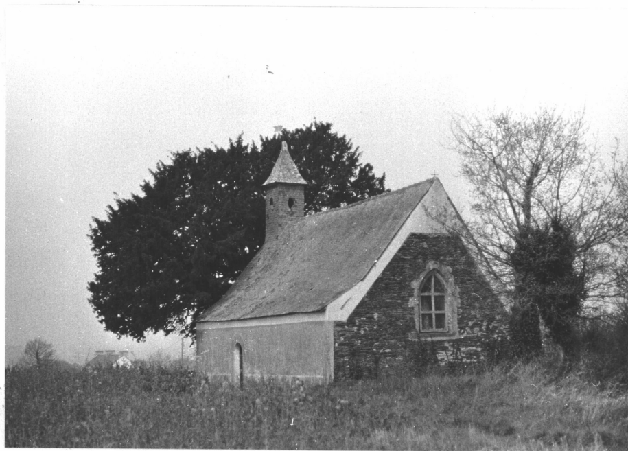
2A/12 - Vue générale Sud-Est de la chapelle, isolée au sommet d'un monticule. Le volume très simple, à pignons aigus, est coiffé à l'Ouest d'un petit clocher en bois.
