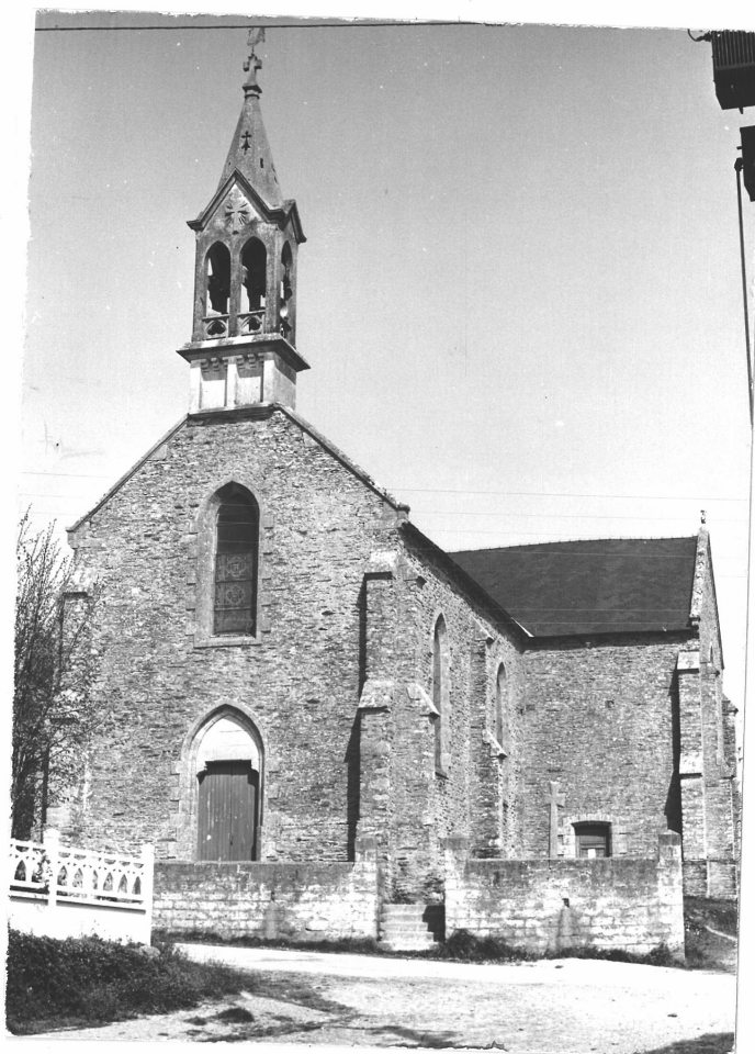
96/17 - Vue générale prise du Sud-Ouest ; la chapelle de grandes dimensions, fut construite au XIX e siècle dans un style néo-gothique peu orné.
