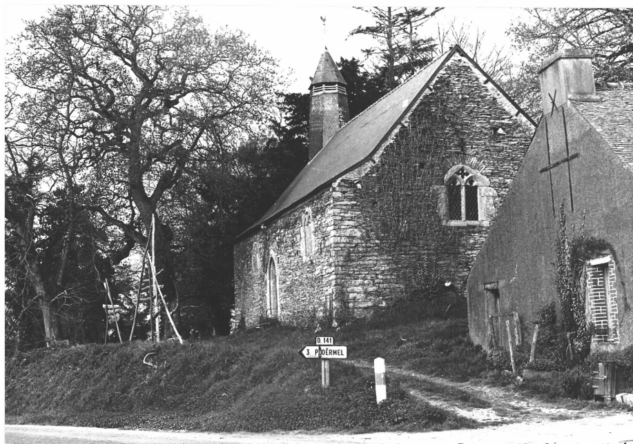
13/32A - Vue de situation de la chapelle plantée sur une colline culminant à 87m. De plan rectangulaire, elle est coiffée d'une toiture à coyaux sommée à l'Ouest d'un petit clocher en bois. Elle remonte au début du XVI e siècle.
