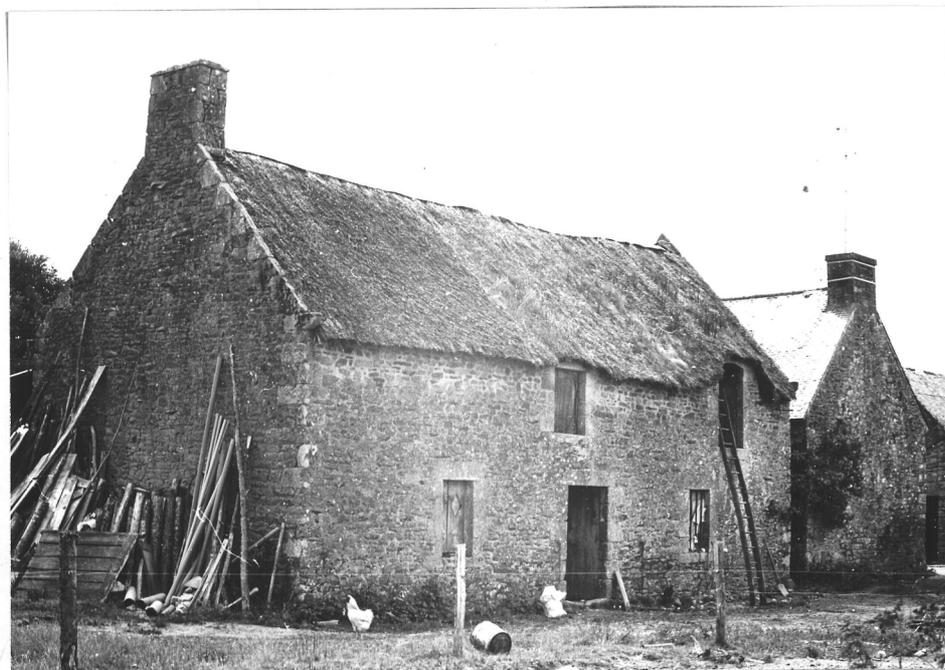
48/33 - Maison B. Autre logis, à deux niveaux, plus récent (XIX<sup>e</sup> siècle), également couvert en chaume et transformé en dépendance. Construction soignée avec chaînages d'angle, rampants des pignons à pierres taillées en sifflet et pierre d'assise en quart-de-rond.
