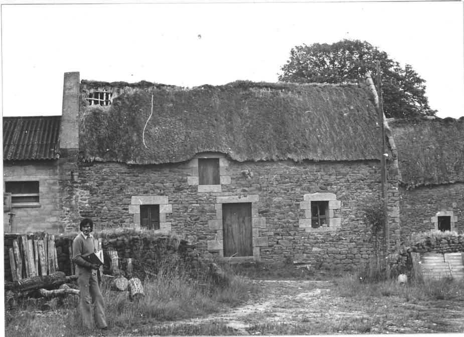
43/4 - Ancien logis ? à proximité de la demeure du XVI e siècle. Les formes et les encadrements des baies à angle vif annoncent une construction probablement du XIX e siècle.
