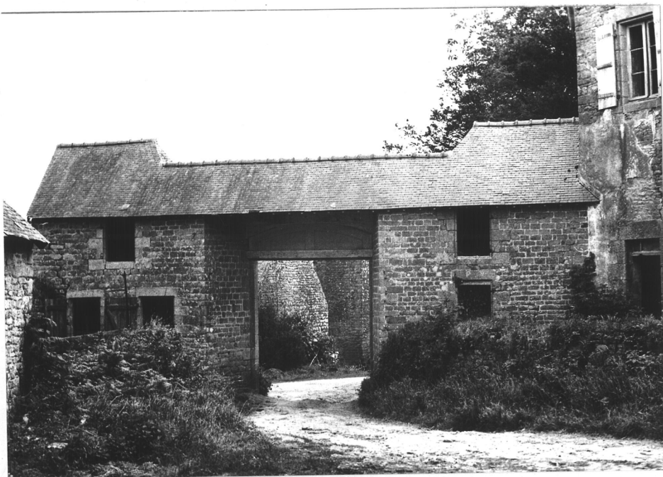
64/15 - Le portail d'entrée, vu de la cour.
