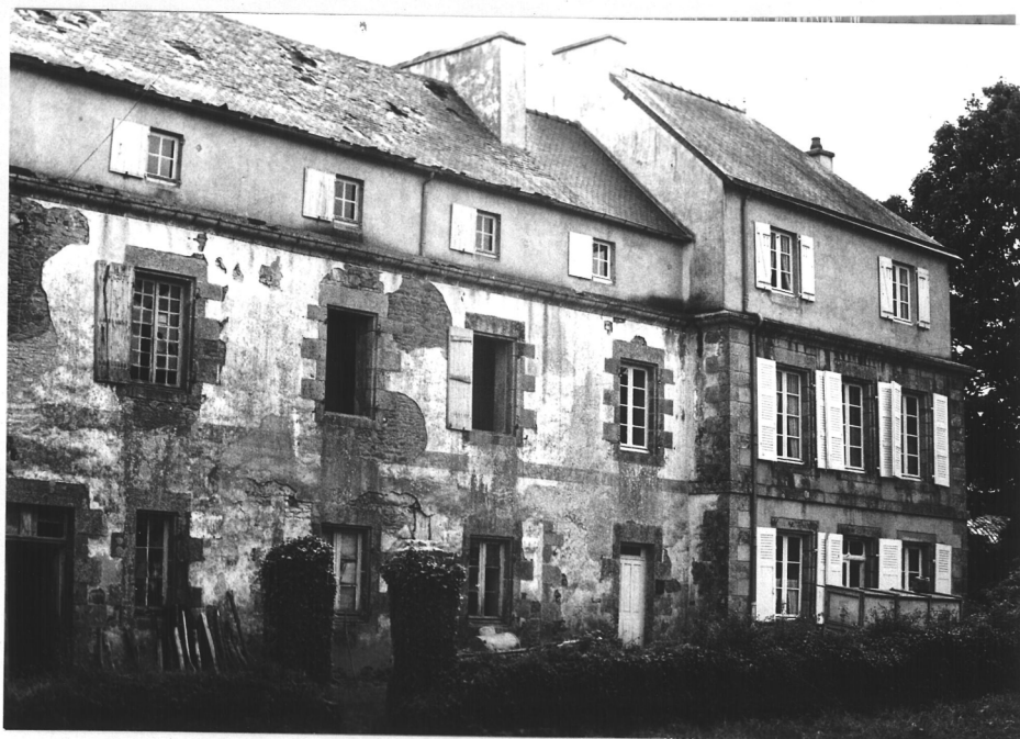
64/16 - Le logis, du XVIII e siècle, comportant un étage carré et un étage attique, se divise en deux corps dont l'un, plus élevé que l'autre, abrite l'escalier. Élévation à travées, baies rectangulaires à feuillure. La partie Est (à gauche sur la photo), très délabrée, conserve des boiseries et une cheminée en marbre Louis XV.
