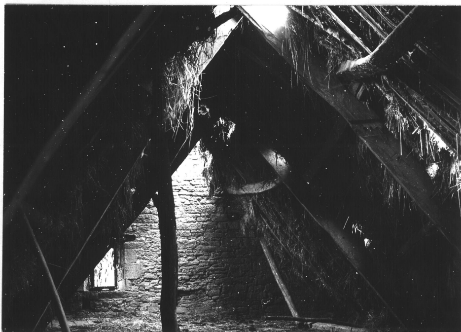
46/21 - Vue de la charpente qui semble avoir été remaniée (les arbalétriers notamment). Système dépourvu d'entrait retroussé et de poinçon.
