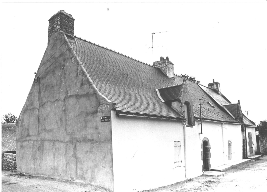
10/16 A - Elévation Nord. Les deux logis accolés ont un plan allongé, une élévation à un seul niveau et comble à lucarnes pendantes. Cette construction, peut-être du XVII e siècle conserve ses proportions et ses ouvertures d'origine, mais elle n'a rien gagné à être crépie.
