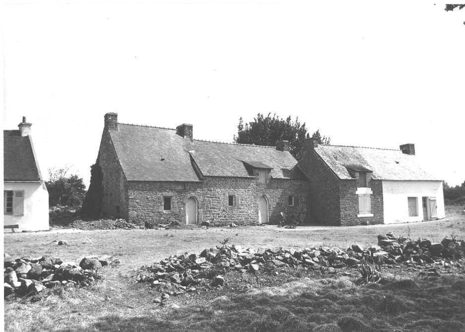
41/31 A - Logis au Sud de la "rue". Un niveau et comble à lucarne, desservi par un escalier extérieur en pierre, à une volée droite. La cheminée à décor géométrique subsiste. A droite, four rectangulaire et à abside.
