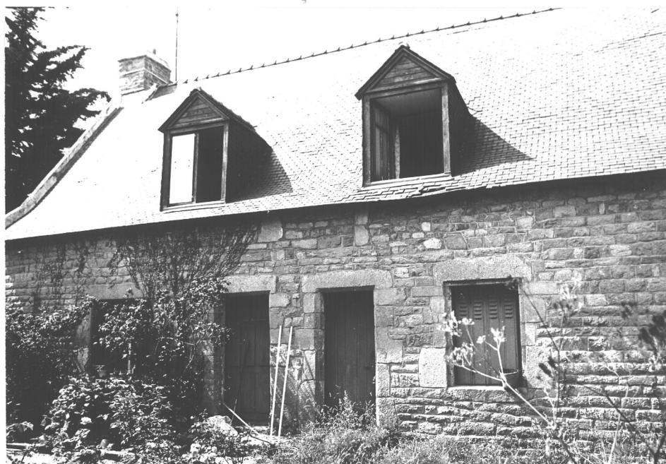
35/SN - Logis au centre du hameau. Remanié dans les parties hautes (les deux lucarnes rentrantes ont remplacé la lucarne pendante dont les traces subsistent) il conserve la forme ancienne de sa toiture commandée par le mouvement du pignon.
