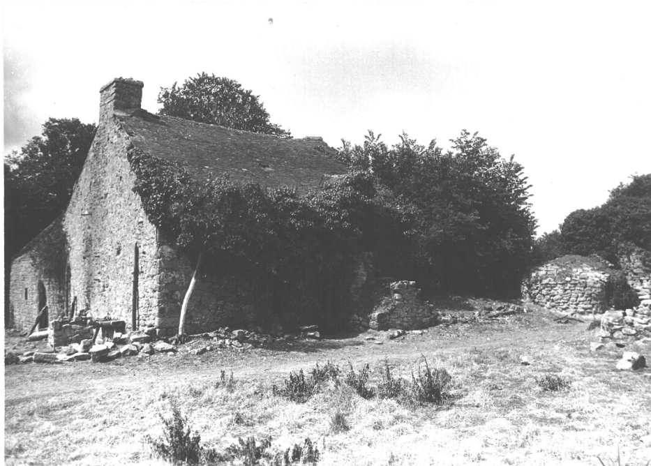
41/31 A - Logis au Sud de la "rue". Un niveau et comble à lucarne, desservi par un escalier extérieur en pierre, à une volée droite. La cheminée à décor géométrique subsiste. A droite, four rectangulaire et à abside.
