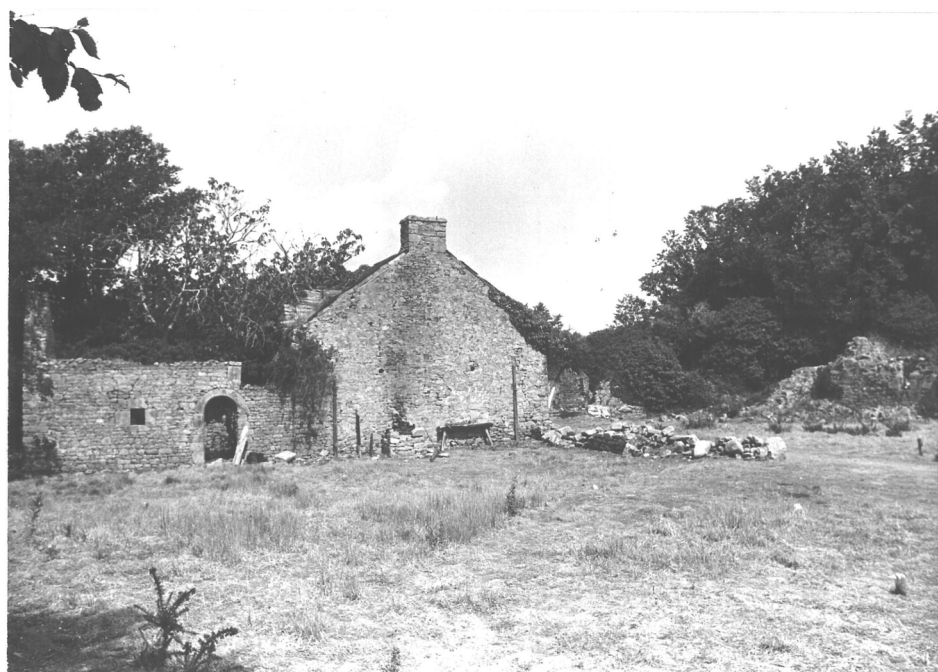
40/24 A - Logis disposés en équerre sur le côté Sud de l'alignement. Construction en petit appareil régulier, baies à encadrement soigneusement taillé.
