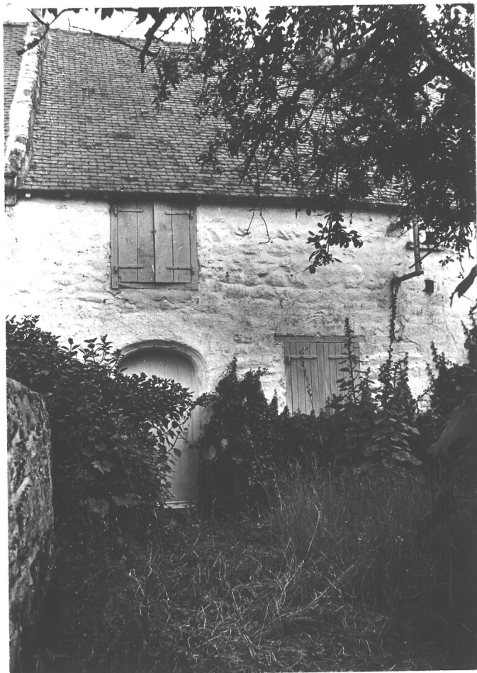
10/13 A. - Maison rue de La Fontaine. Petit logis à deux niveaux, le second dans le comble à surcroît; façade passée au lait de chaux. Porte en anse de panier soigneusement moulurée. Au second niveau, à droite, trous de boulins pour les pigeons.
