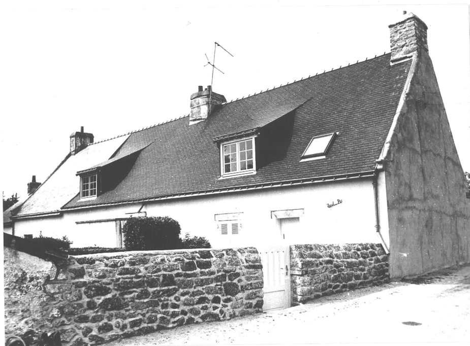
11/19 A - Elévation postérieure Sud, très remaniée, ayant perdu tout intérêt.
