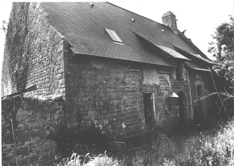
36/1 - Au Sud, du hameau, beau logis du XVII e ou du XVIII e s., malheureusement abîmé dans sa partie Nord. Constitué d'un niveau et d'un comble à lucarne passante, il se signale par la qualité de l'appareil et de sa mise en oeuvre, la présence de boulins pour les pigeons, la forme des pignons, recourbés à partir des deux assises inférieures.
