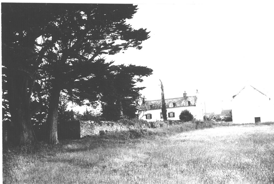
9/7 A - Rurale par sa situation, cette construction se caractérise en fait surtout par son appartenance au type dit "maison de capitaine" : c'est un grand logis à deux niveaux avec cour et jardin cernés de murs.
