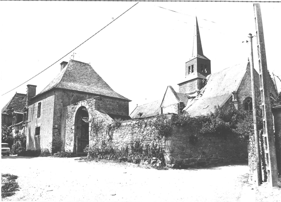
22/2 A - Vue générale de l'église et de son ancien prieuré, prise du Sud-Est. (on rêverait d'une présence moins insistante de l'E.D.F. → EDF a enterré les fils
