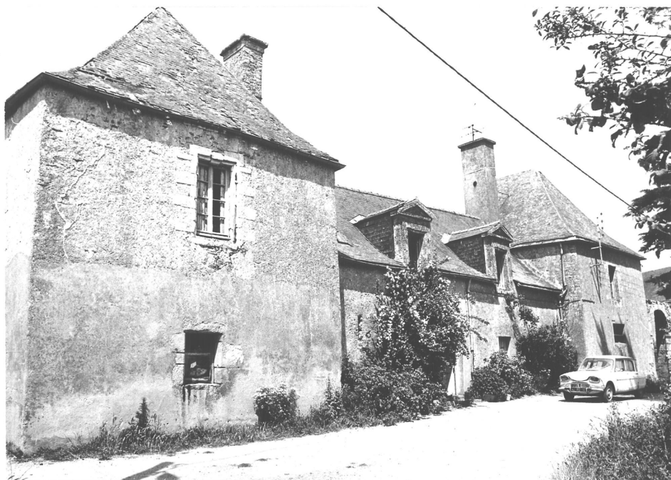
22/4 A - Elévation Sud du prieuré. Le bâtiment, du XVII e siècle, est constitué d'un corps central d'un seul niveau avec comble à lucarnes pendantes et de deux pavillons saillants à deux niveaux. Les pavillons étaient autrefois munis de lucarnes en tuffeau comme celle qui subsiste à l'Ouest sur l'élévation postérieure.
