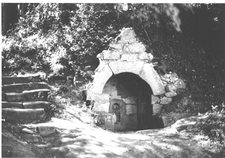
26/23A - Cette fontaine, pouvant dater du XVII e ou du XVIII e siècle est la seule dont le caractère religieux est évident. Adossée à un repli de terrain, elle consiste en une simple niche voûtée en berceau et présentant en façade un fronton triangulaire appareillé, très dégradé.
