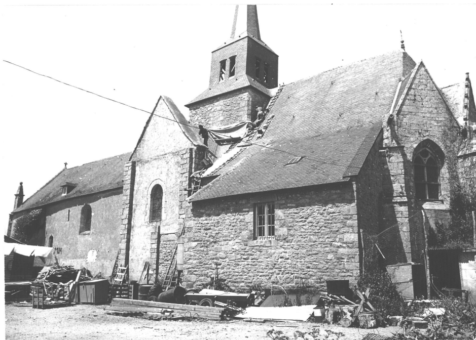
20/33 A - Vue générale Sud-Est.
