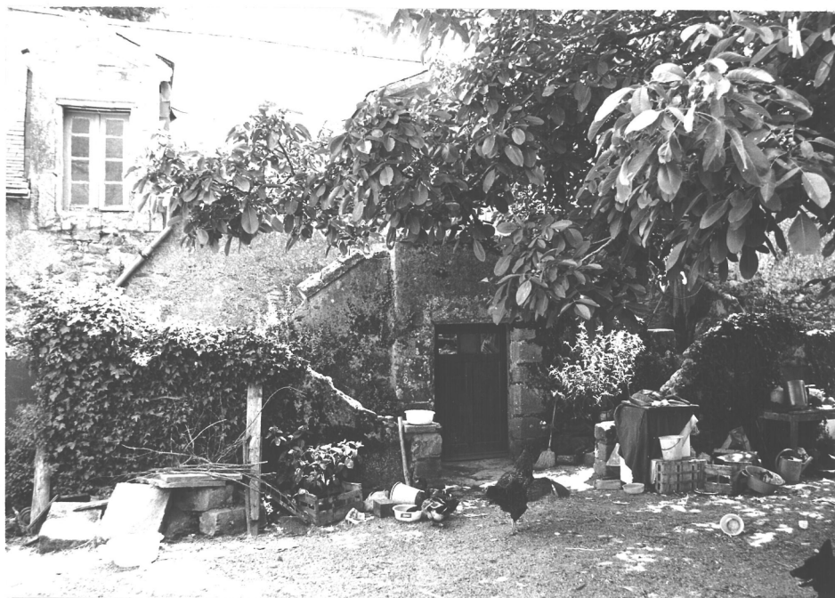
23/6 A - Elévation sur cour avec l'escalier extérieur en pierre à double volée.
