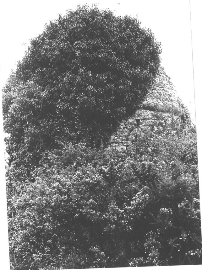
11/15 - MOULIN DU RINVILLE - Sous le lierre on en devine l'appareillage en pierre sèche et la structure à deux niveaux dont un en léger encorbellement.
