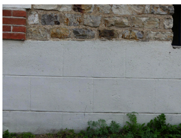
Enduit imitant la pierre de taille
