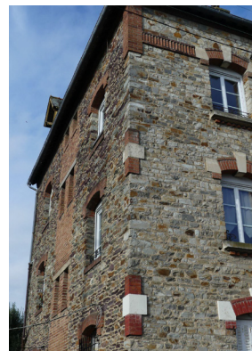
Chaînage d'angle discontinu
