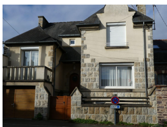
Mur de clôture identique au soubassement
