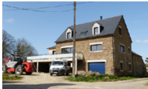
Travaux de restauration dénaturant le bâti traditionnel
