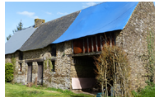
Poser des tôles pour protéger le bâtiments en attendant de futurs travaux
