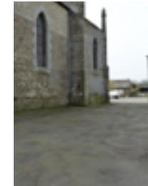
Proscrire le bitume jusqu'au pied de mur - Risque d'humidité
