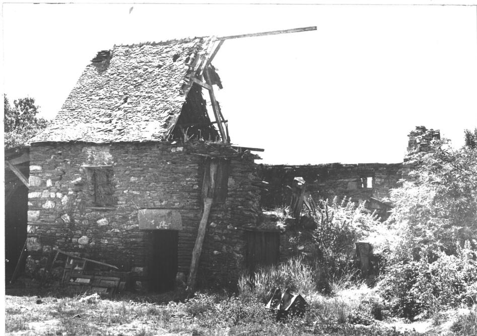
11/11 A - Façade Nord. Cet ensemble voué à une prochaine disparition conserve dans sa partie gauche des chaînes d'angles en grès de grande taille ainsi qu'un grand linteau en schiste violet qui repose sur un appareil de schiste foncé très régulier et soigné.
