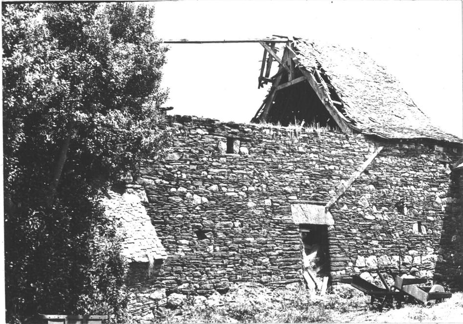
11/12 A - Façade Sud : le logis ancien construit en appareil mélangé de schiste et de grès avec grands linteaux de porte en schiste violet. C'est un édifice caractéristique de la tradition locale par son matériau et son type de charpente, bien visible ici.
