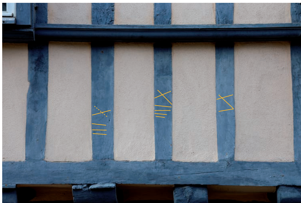
Fig. 51 : marques XIII, XIII et XV entre les fenêtres O15 et O16 © T. Béthus, R. Louessard, Inrap
