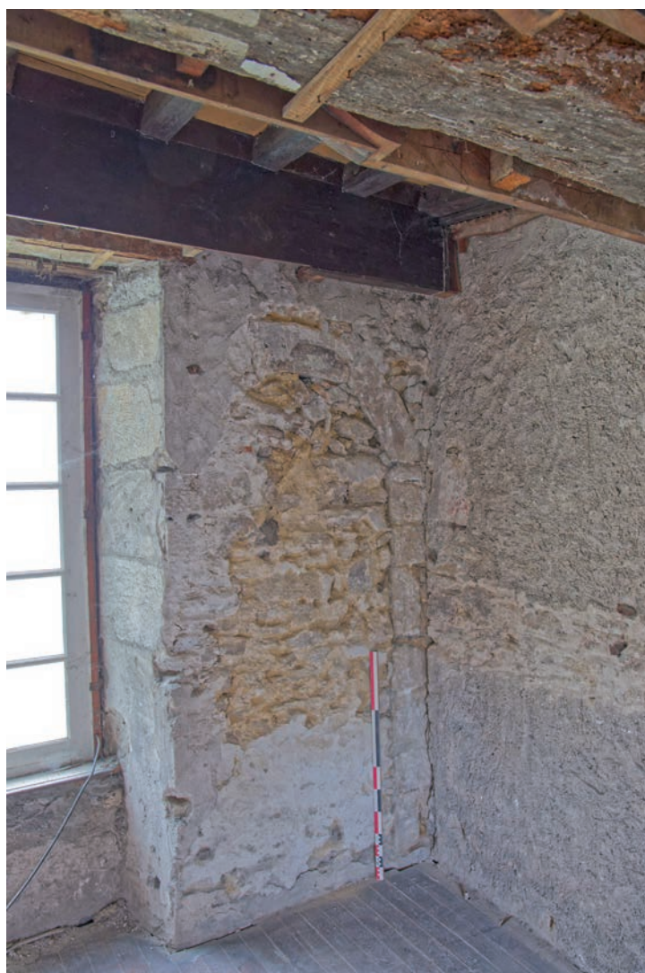
Fig. 34 : la porte bouchée O25 © R. Louessard, Inrap
