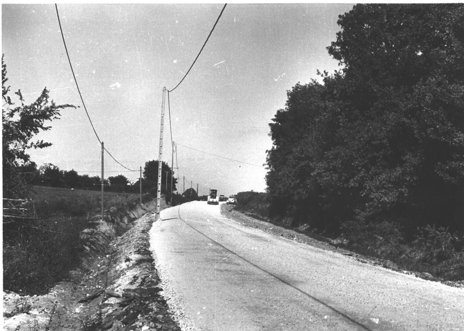
9/34 - Route en travaux, au Sud de la commune.
