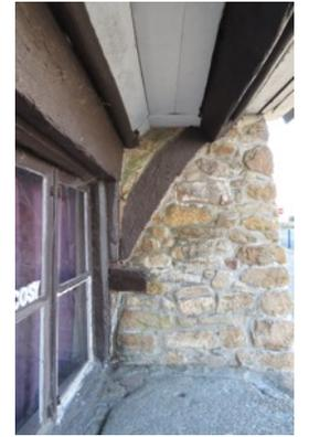
L'encorbellement de la façade principale – ajout d'un massif maçonné. Ce massif maçonné a été probablement ajouté peu après la construction de la maison pour stabiliser le faux aplomb important de la façade (de l'ordre de 26 cm aujourd'hui).
