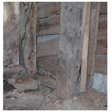
**Traces** : la présence d'une rainure sur chaque côté et sur toute la hauteur des poteaux, des arêtes chanfreinées ainsi que des restes du torchis.
