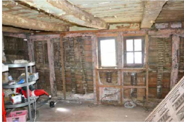
La façade nord en pan de bois est composée d'une lisse haute et basse avec 8 poteaux. Avec la présence de l'habillage en ardoise, il est impossible d'observer les traces de contreventement et d'assemblage permettant de définir le nombre d'ouvertures aménagées à l'origine. Les pièces de bois secondaires ont été rapportées ultérieurement et sont simplement clouées.
