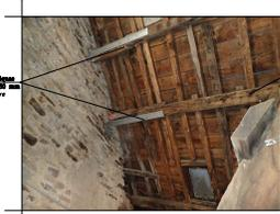
Photo N°7 - Reinforcement des pannes par cornières métalliques
