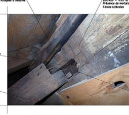
Photo N°7 - Assemblage ouvert écharpé
