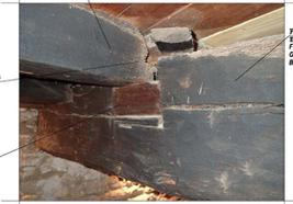
Photo N°2 - Exemple appui précocé solive
