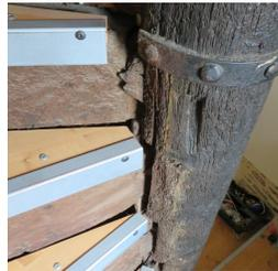
Noyau chêne nécrosé — renforcement par profilé métallique
