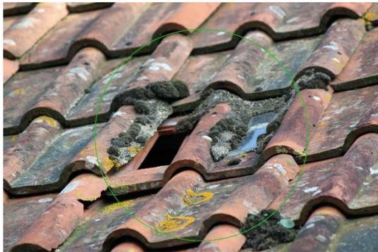
La photographie montre bien l'espace laissé à la manufacture dans la tuile gauche pour y poser un pavé de verre (auteur : Alain Bohée). A droite, ce pavé installé dans la tuile.
