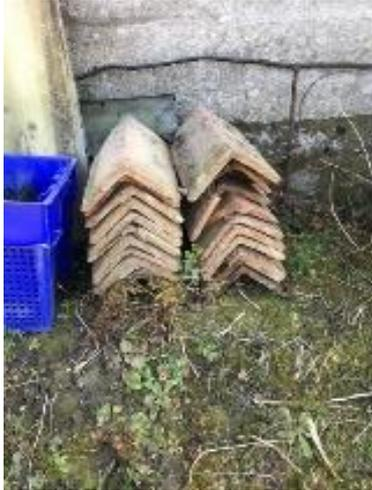
Les faîtières ordinaires : ce type de faîtières simple sans emboîtement est fabriqué par les deux manufactures, estampillé à leur nom et est maintenu sur la crête du toit par du mortier, ce qui les rend, à plus ou moins long terme, plus susceptibles aux infiltrations d'eau de pluie. Dimensions 46 cm avec à l'équerre de lèvres de 17 cm.
