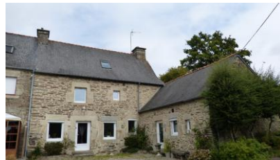
Proscrire PVC et les menuiseries a un seul carreau, les enduits ciment, les lucarnes disproportionnées
