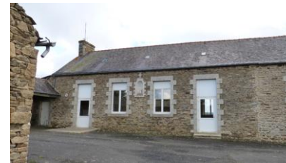
Proscrire PVC et les menuiseries a un seul carreau, les enduits ciment, les lucarnes disproportionnées
