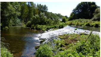
Bief et digue - Moulin des Essarts
