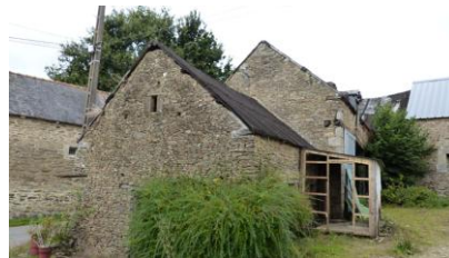
Dommage de démolir du bâti - Le Montrel
