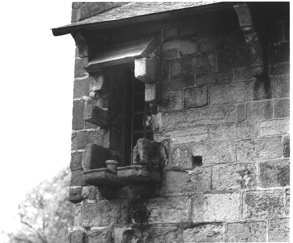
Fig.8 Moulin, mur nord, corbelet supportant le toit et évacuation d'un évier
