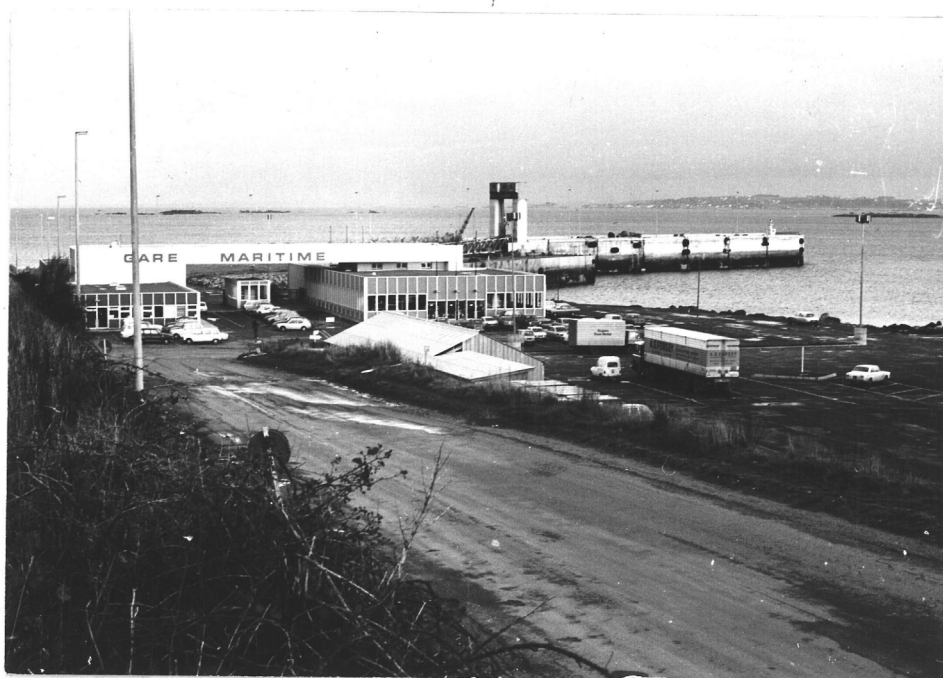
50/33 - Ensemble des installations.
