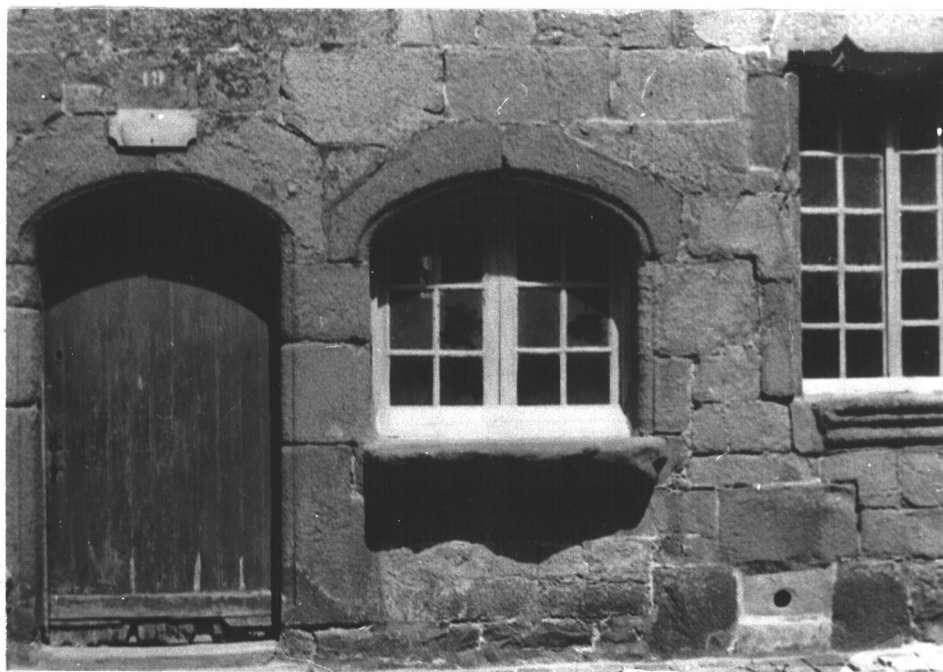
26/9 - Ouvertures de la façade.
