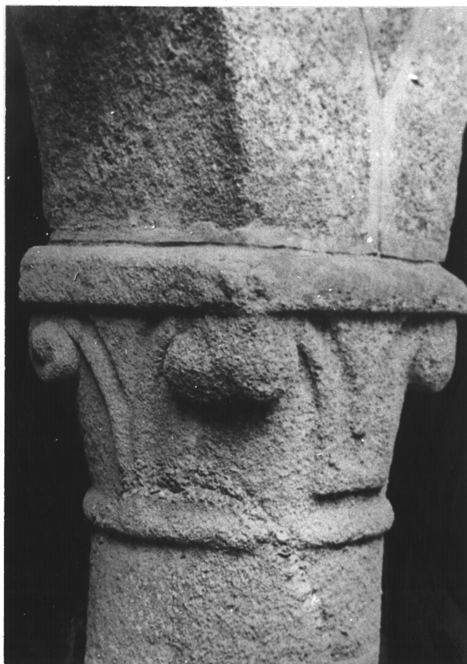
34/23 - Détail de chapiteau.
