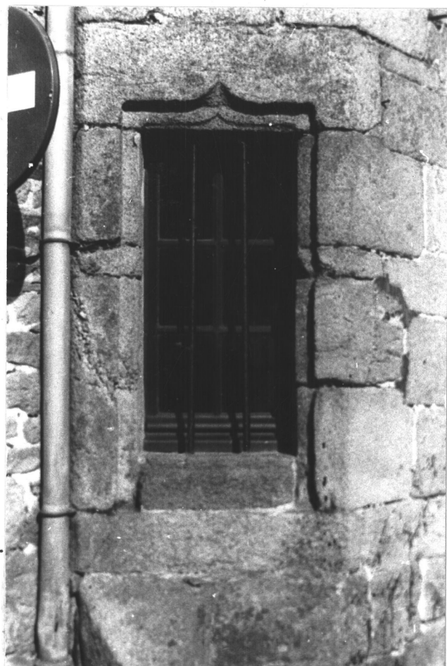
30/35 - Fenêtre rez- de-chaussée, angle Sud-Est .. (1572).
