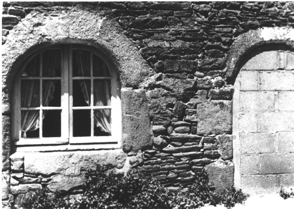
25/3 - Détail des ouvertures - n°79.
