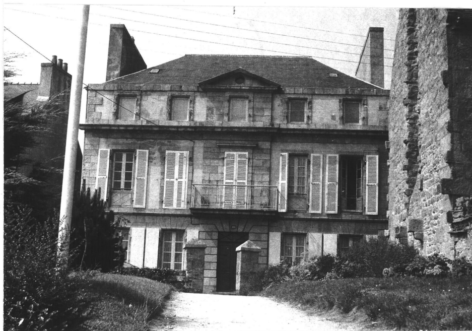
2/30 - Elévation antérieure. Balcon appareil. Parti général rare en Bretagne (évoquant plu- tôt le midi avec l'attique).
