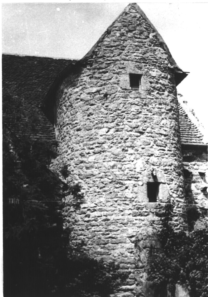
39/18 - Détail de la tourelle d'escalier.
