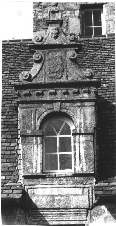
33/19 - Détail lucarne Nord.
