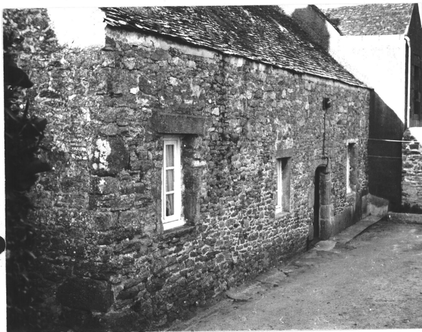
14/4A - Vue du Nord - Ferme n°2.
