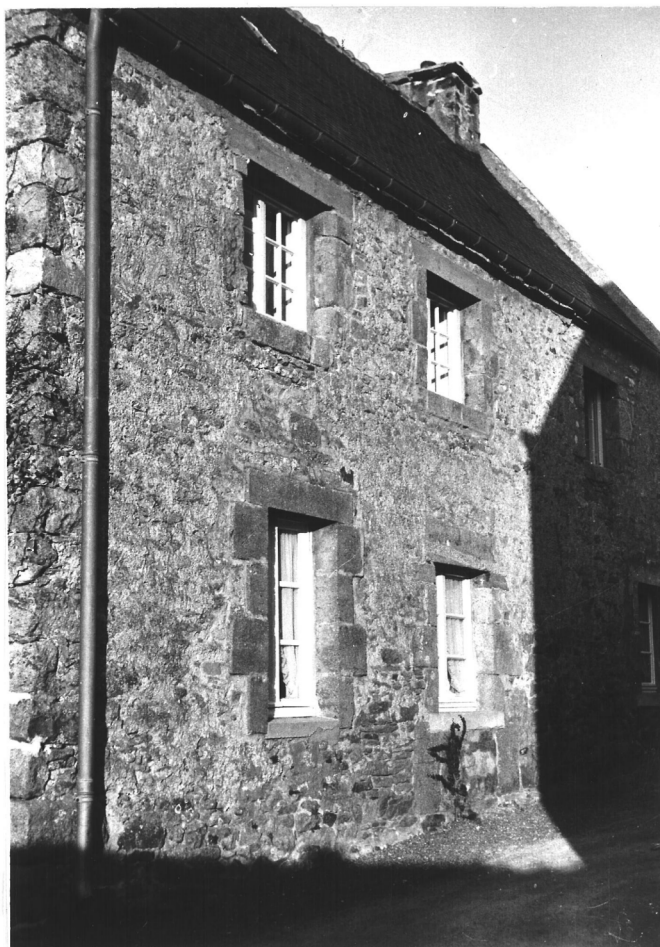
15/6A - Vue générale.
