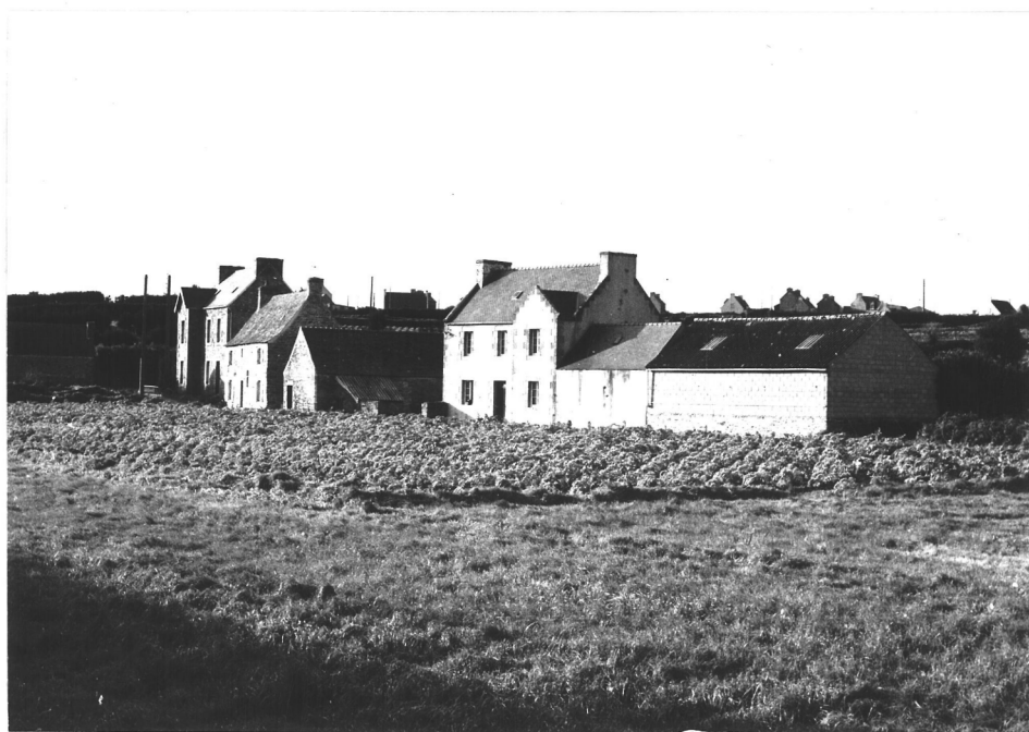
51/7A - Fermes de Penprat. Contraste entre le bâtiment le plus vieux (3° à partir de la droite) au volume et aux lignes harmonieuses et les autres bâtiments aux formes et aux matériaux médiocres.
