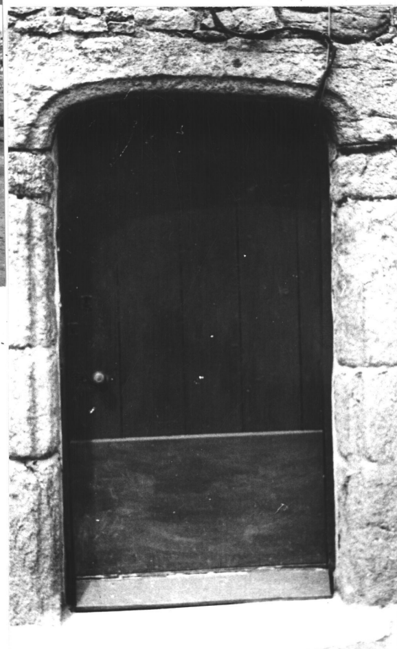
27/16 - Détail porte, ferme n°2.
