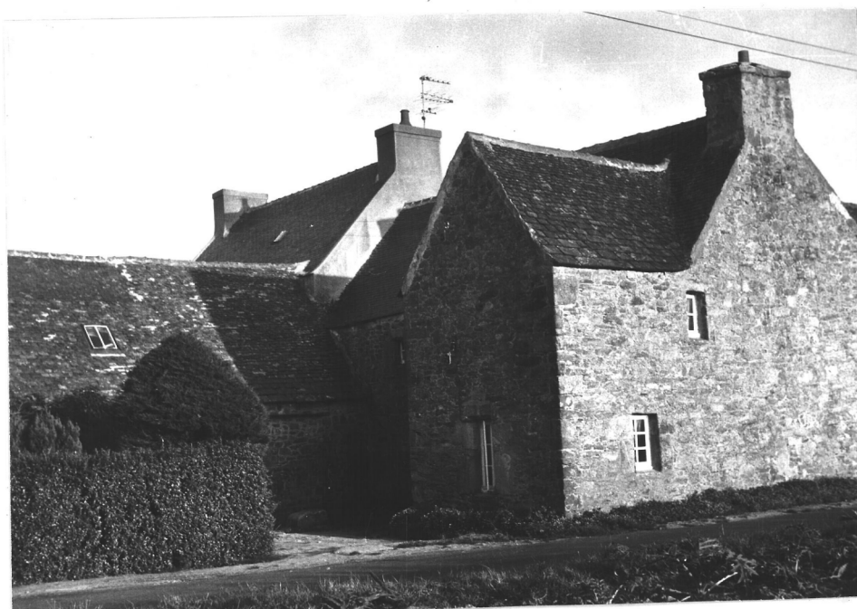
15/11A - Vue du Nord-Ouest.
