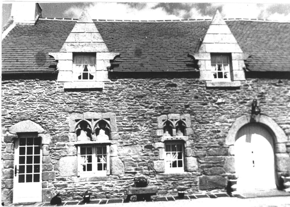
32/8 - Maison restaurée avec réutilisation d'éléments anciens (XIV e siècle). Lucarnes modernes.
