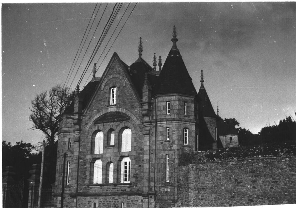
15/10A - Vue du Sud-Ouest.
