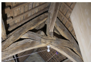
Corps principal (partie ouest), charpente de comble, 1ère ferme depuis l'ouest, vue depuis l'est
