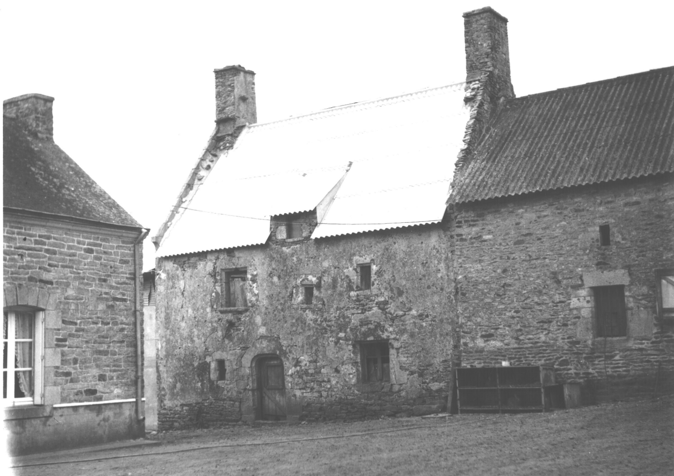
Maison XVII e siècle - A l'intérieur, escalier en vis distribuant l'étage.
