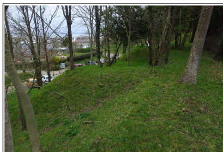
Traverses perpendiculaires au parapet de l'enceinte urbaine du Palais (IVR53_20175608198NUCA)
