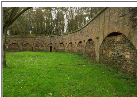
Casemates à feux de revers de l'enceinte urbaine du Palais (IVR53_20175608478NUCA)
