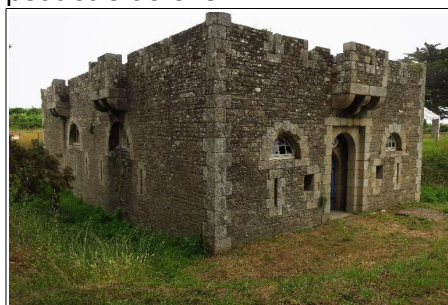
Corps de garde défensif de la batterie du Gripp à Groix (IVR53_20175606538NUCA)
