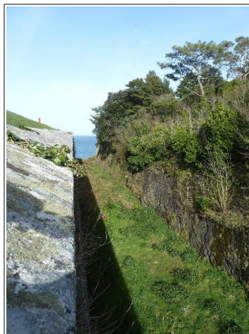
Contrescarpe de la courtine 18 de l'enceinte urbaine du Palais (IVR53_20175608042NUCA)
