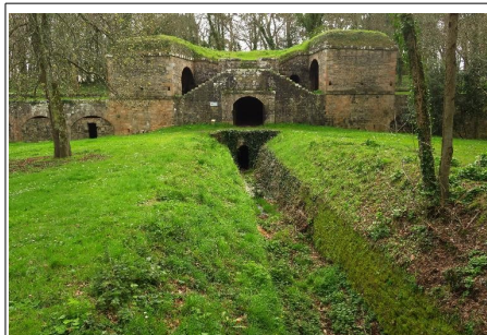
Caponnière reliant le corps de place du Palais au réduit H (IVR53_20175608571NUCA)
