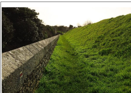
Mur à bahut de la courtine 18 de l'enceinte urbaine du Palais (IVR53_20175608048NUCA)
