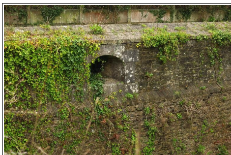
Embrasure d'artillerie dans un parapet de l'enceinte urbaine du Palais (IVR53_20175608357NUCA)
