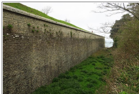
Escarpe de la courtine 18 de l'enceinte urbaine du Palais (IVR53_20175608041NUCA)
