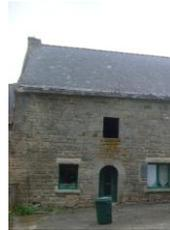
Elargissement des ouvertures, linteau inadéquate, appui en ciment
