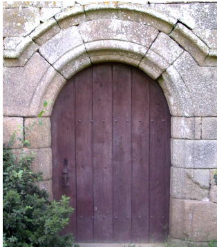
Menuiserie ancienne : porte pleine en assemblage de planches
