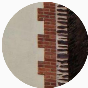
Chaînage d'angle en brique
