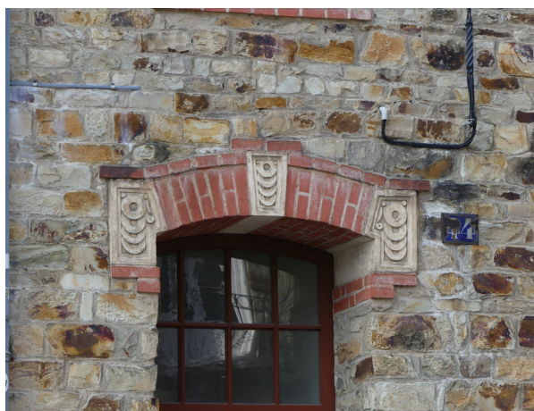
Fig. 143 : Détail sur le motif des anneaux moulés dans le ciment du 44 rue Etienne Dolet, 1912.
