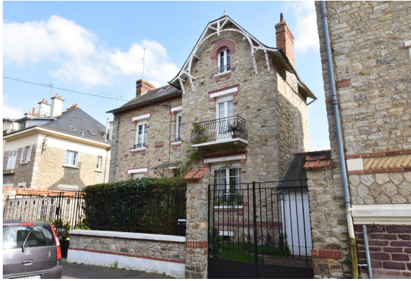
Fig. 40 : Maison en retrait d'alignement.
