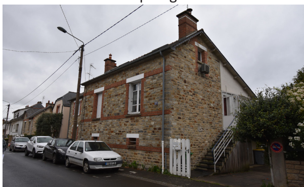
Fig. 57 : Maison 23 rue Gabriel Fauré, date inconnue.
