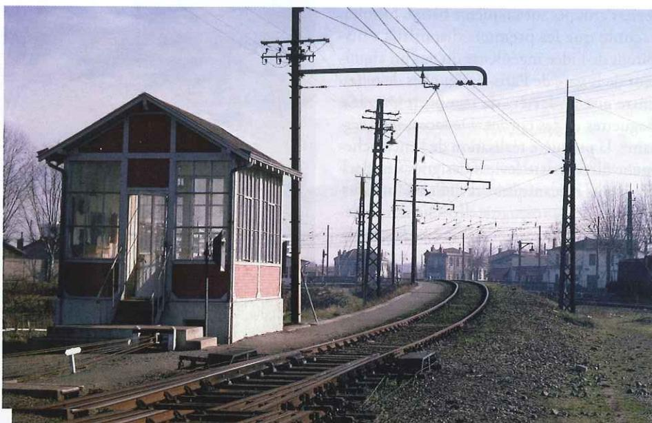
Regroupant l'ensemble des installations permettant de manoeuvrer signaux et aiguille, un poste ne comporte pas toujours une cabine pour l'abriter, tel celui-ci, installé le long du BV de la gare d'Aurillac.
