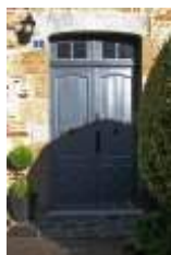
Travaux respectueux du caractère d'origine du bâti : menuiseries bois peintes avec leurs dessins anciens, volets,...
