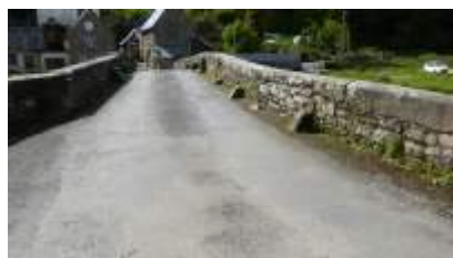
Pont du Couesnon - Couesnon
