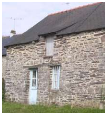
Menuiserie de couleur bleu clair avec une porte d'un seul battant. Menuiserie pleine de la gerbière Barreau à la fenêtre
