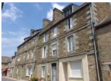
Immeuble à logements
