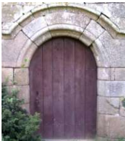
Menuiserie ancienne : porte pleine en assemblage de planches
