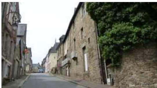
Bâtiment et ancienne prison
