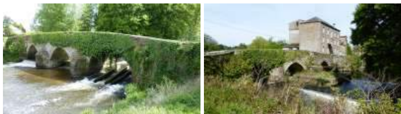
Pont du Couesnon - Couesnon
