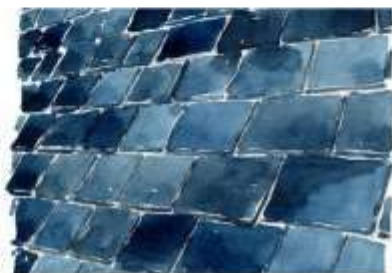
L'ardoise impose une pente minimum.
