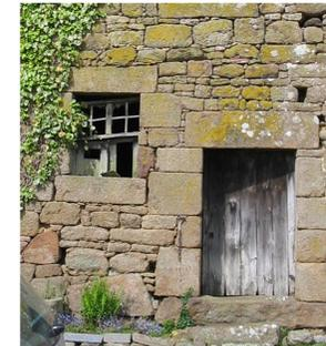
La commune de Coglès étant située sur un sous-sol granitique, le matériau de construction est le granit. Il assure la pérennité de la construction et les différentes techniques de taille permettent d'avoir des modénatures de murs variées. Il a également inspiré le tailleur de pierre pour le décor (cf. Détails architecturaux). Le matériau de couverture est l'ardoise.
