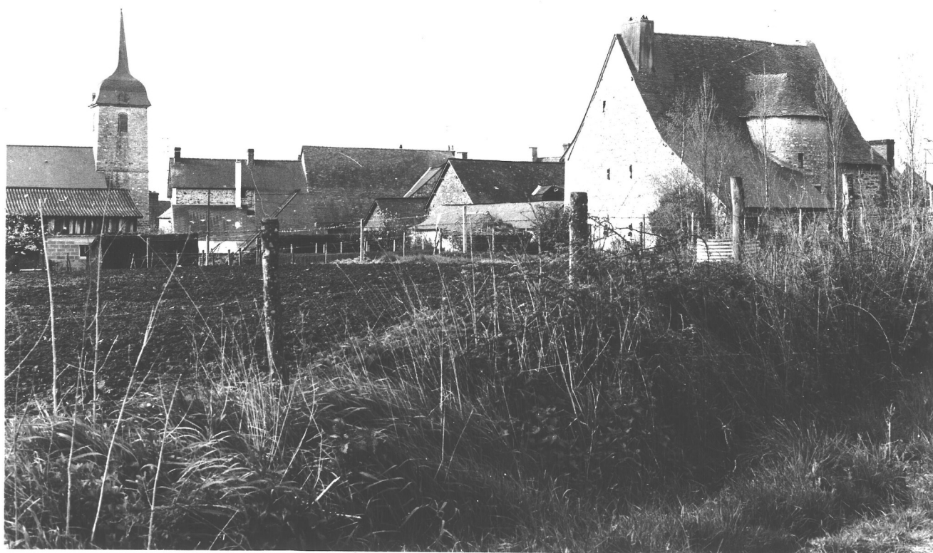
Fig.6/3 - Vue générale Nord-Est.
