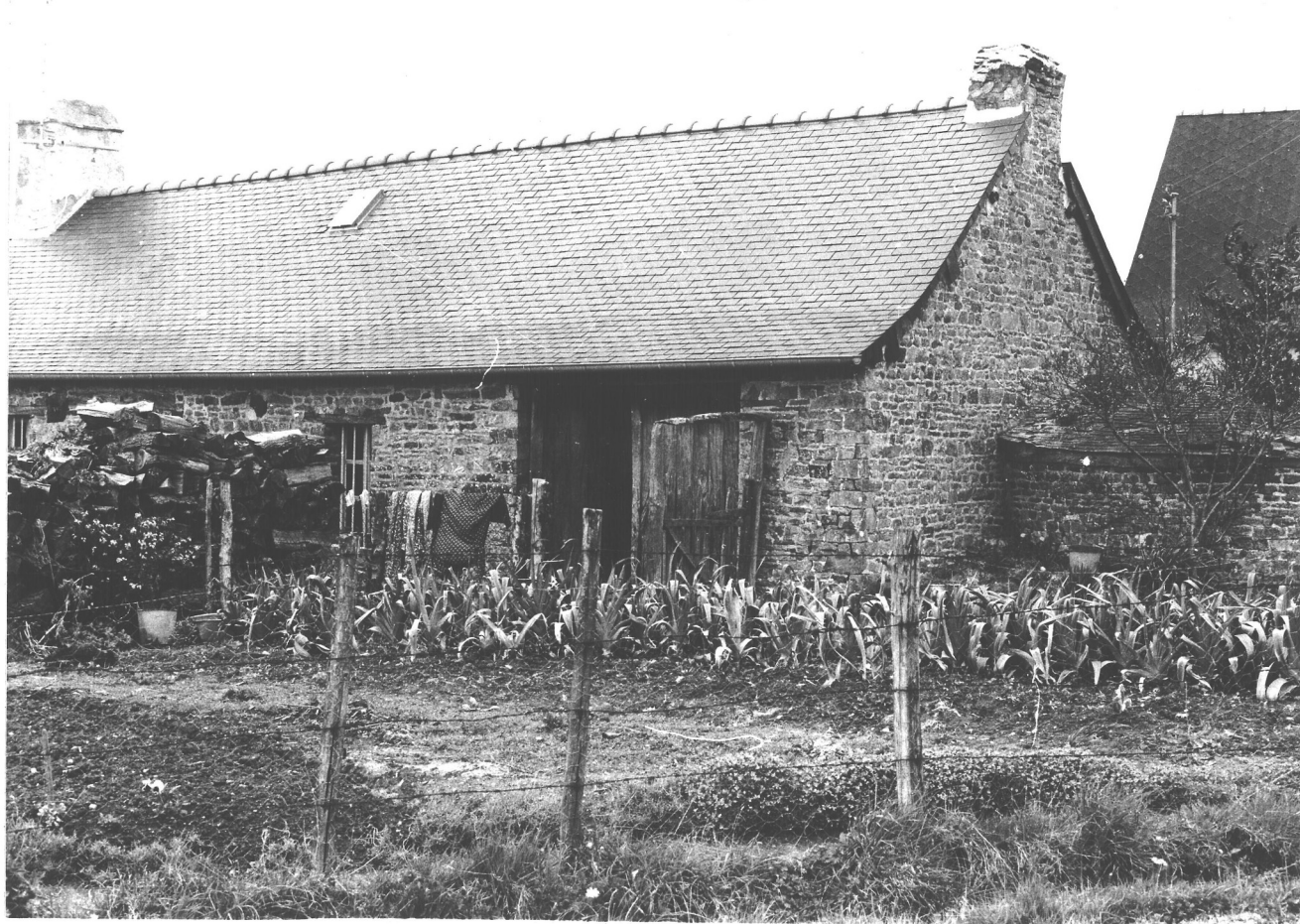
Fig. 4/33 - Vue générale Sud.
