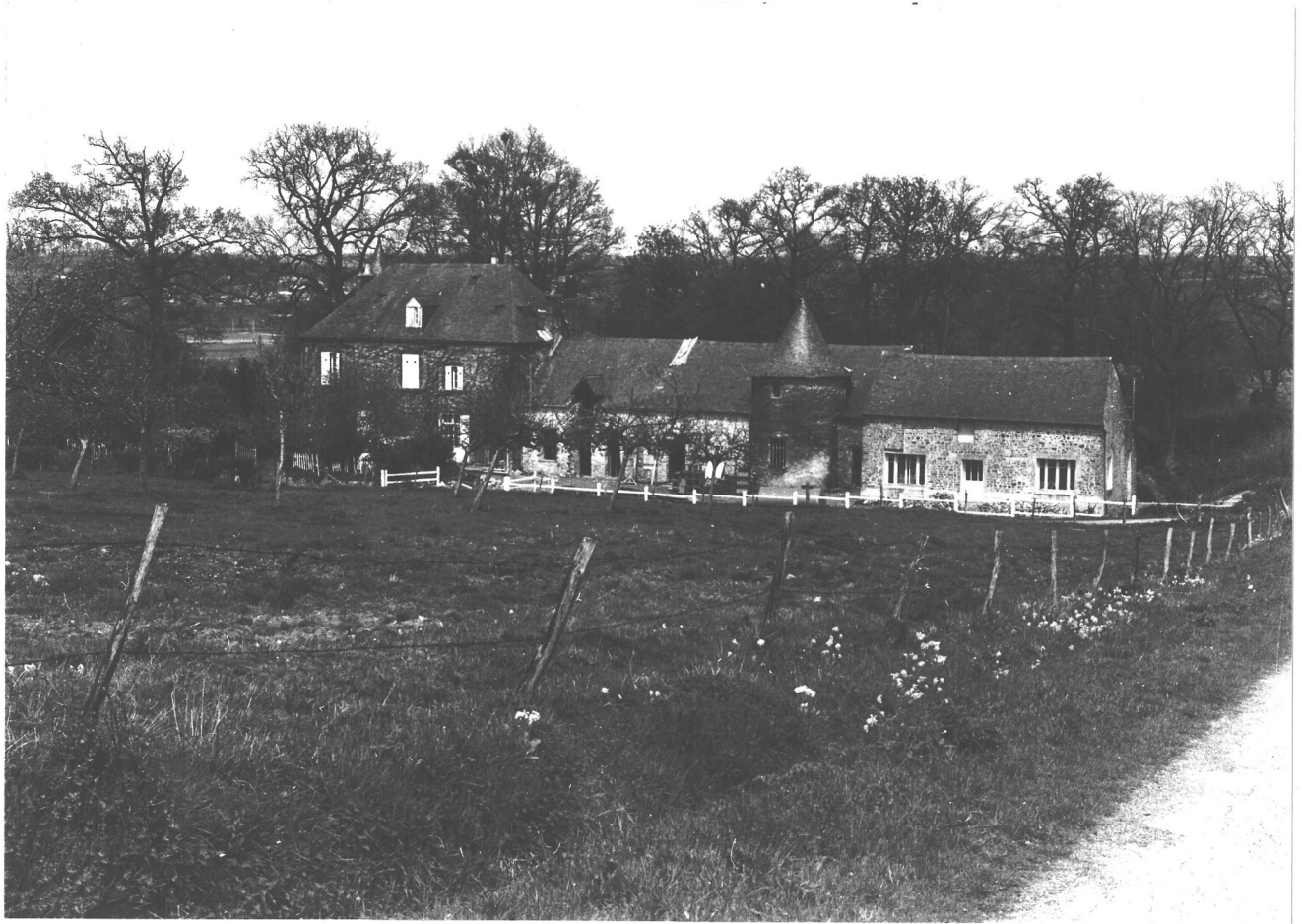
Fig.2/24 - Vue générale Sud.
