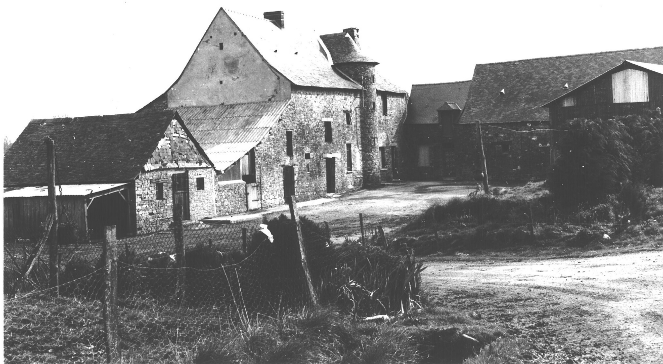
Fig. 6/4 - Vue générale Sud-Ouest.
