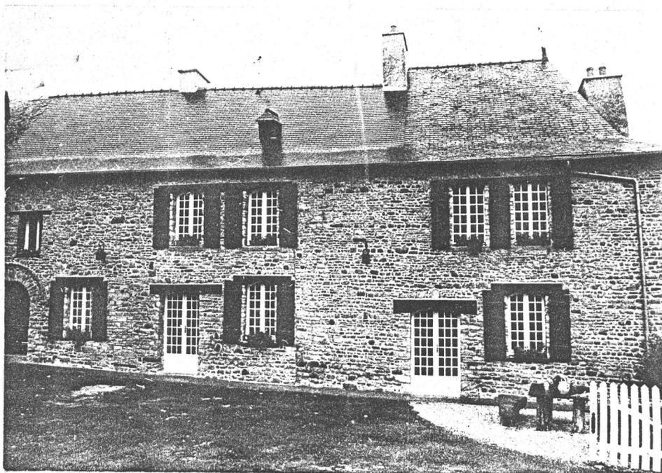
4 A - Elévation Sud. L'édifice, récemment restauré, est dans sa partie Est datée 1779, coiffée d'un toit à croupes. Le niveau de la partie centrale qui conserve une porte en arc plein cintre bloqué au mortier, est inférieur au niveau de la partie droite. Il peut s'agir là de deux époques de construction.
