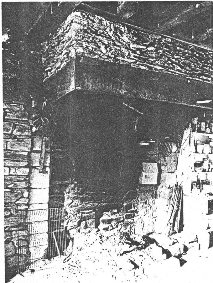
15 A. Corps de bâtiment central, cheminée au rez-de-chaussée de typ engagé avec des consol et un linteau en bois, hotte droite en moëlle de schiste.
