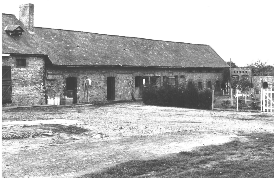
65/3. Aile des dépendances, avec ouvertures et bandeau en briques. A droite les latrines et le chenil, entièrement en briques.
