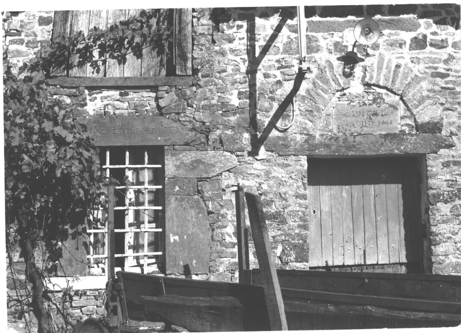
24/27a. Les ouvertures, en schiste gréseux bleuté, sont datées de 1645; l'arc de décharge au-dessus de la porte se rencontre sur plusieurs autres logis datés de la même période.
