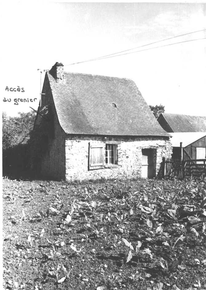
17/24. La Bardouillière. Comble, à surcroît peu important, accessible par le pignon.
