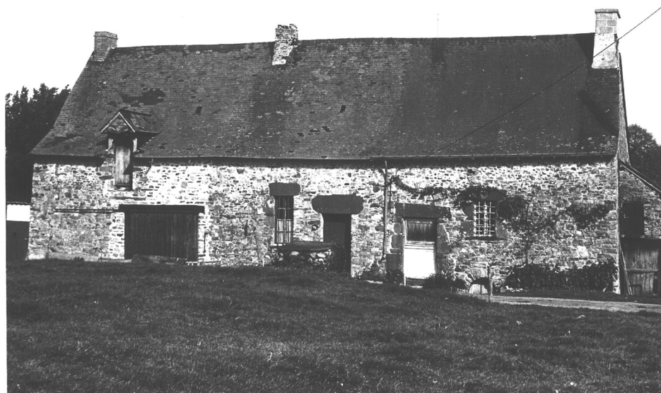
46/5a. Premier alignement Sud, daté 1670: à droite le logis, suivi d'une remise dont les ouvertures ont été remaniées (schiste rougeâtre remplacé par des moellons de grès), et d'anciennes étables.
