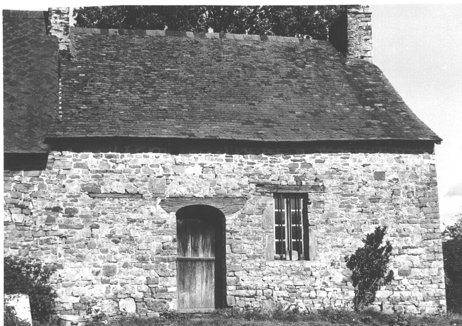
53/7a. Petit logis de la fin du XVIII e siècle situé à l'extrémité d'un alignement et prolongé sur la façade postérieure par un appentis. Ouvertures à piédroits appareillés et linteau en bois; celui de la porte est très bien échancré en anse de panier.
