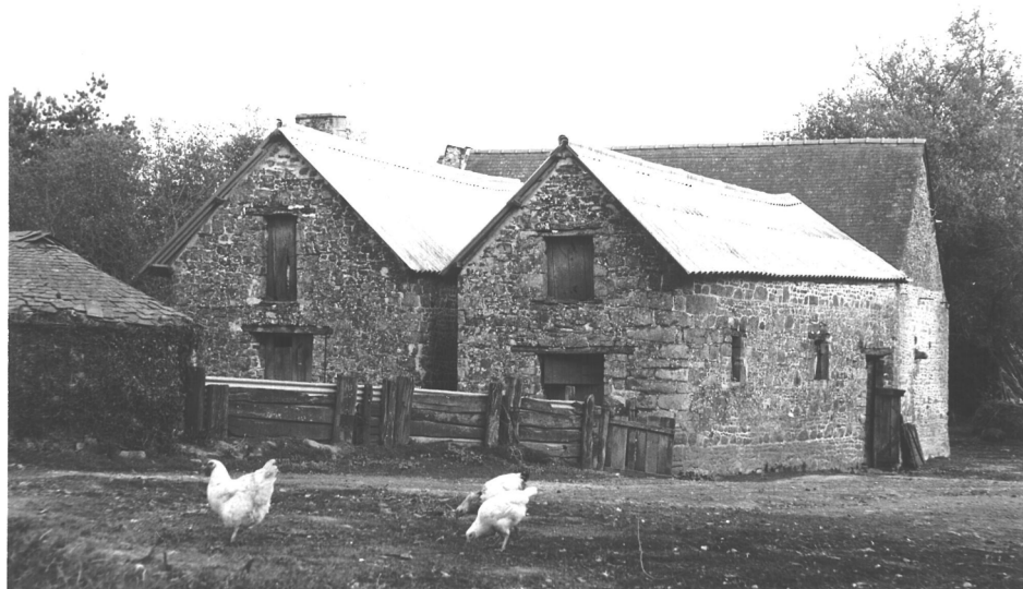
56/27a. Disposition exceptionnelle des dépendances : celles-ci sont formées de deux ailes séparées par une étroite ruelle et greffées perpendiculairement sur la façade postérieure de l'ancien logis.
