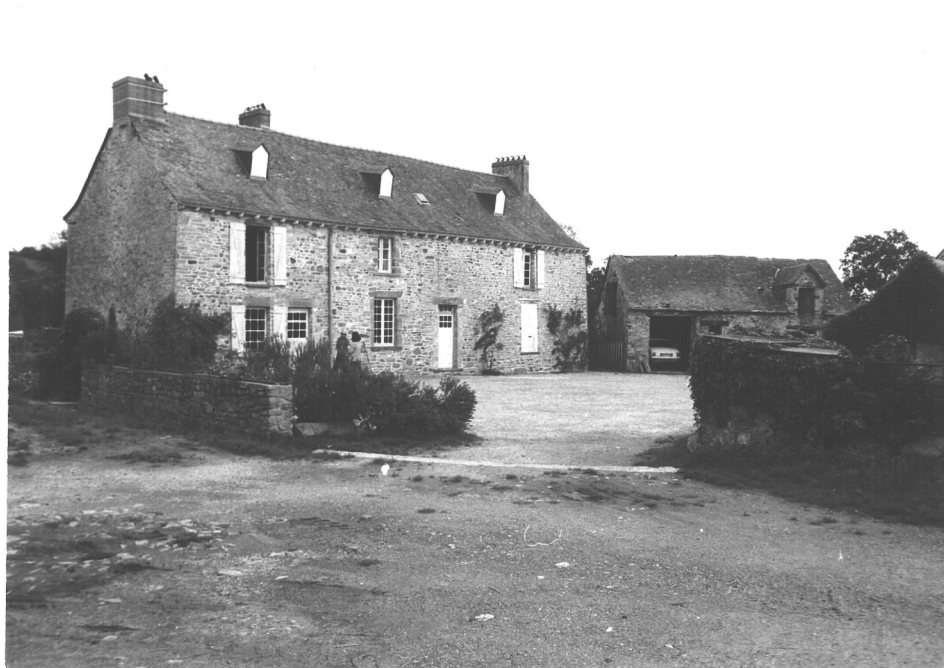
20/3a. Manoir daté 1790 sur une poutre de la salle principale. Ouvertures en schiste gris bleuté sauf dans la partie droite, remaniée.
