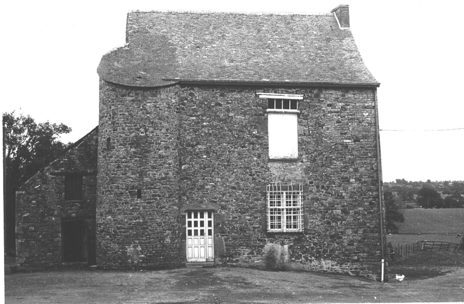
39/2. Le manoir, de la fin du XVI e siècle ou du début du XVII e , se prolongeait à l'origine à gauche de la tourelle d'escalier. La porte haute est une ancienne croisée semblable à celle du rez-de-chaussée,
