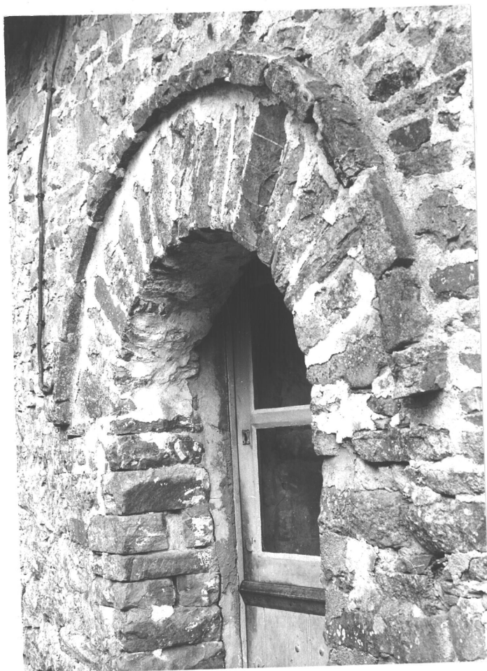
7/s.n. La Bruyère - Porte XVIII e : arc plein-cintre bloqué au mortier et souligné d'un larmier.
