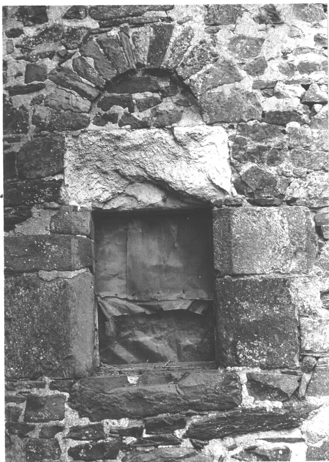
64/34a. Petite fenêtre du XVII e siècle, avec arc de décharge et linteau en calcaire..
