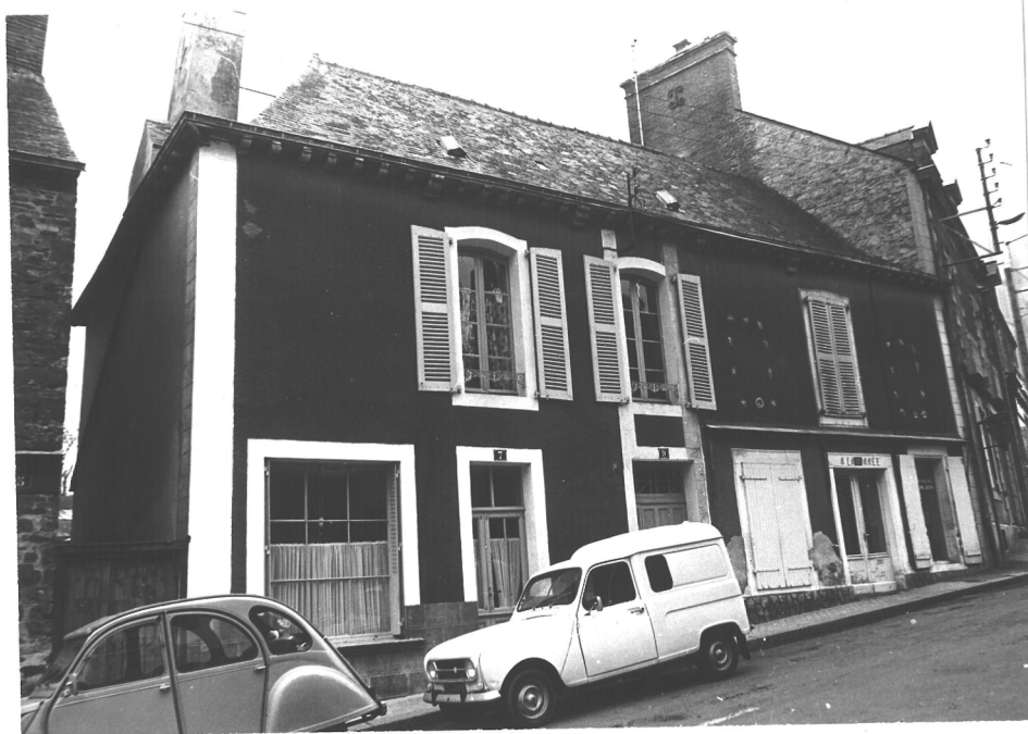
79/10a. Aux numéros 7 à 11 rue Corbin, maison du XVII e siècle, à façade remaniée, mais conservant des corbelets galbés relevant la pente du toit.
