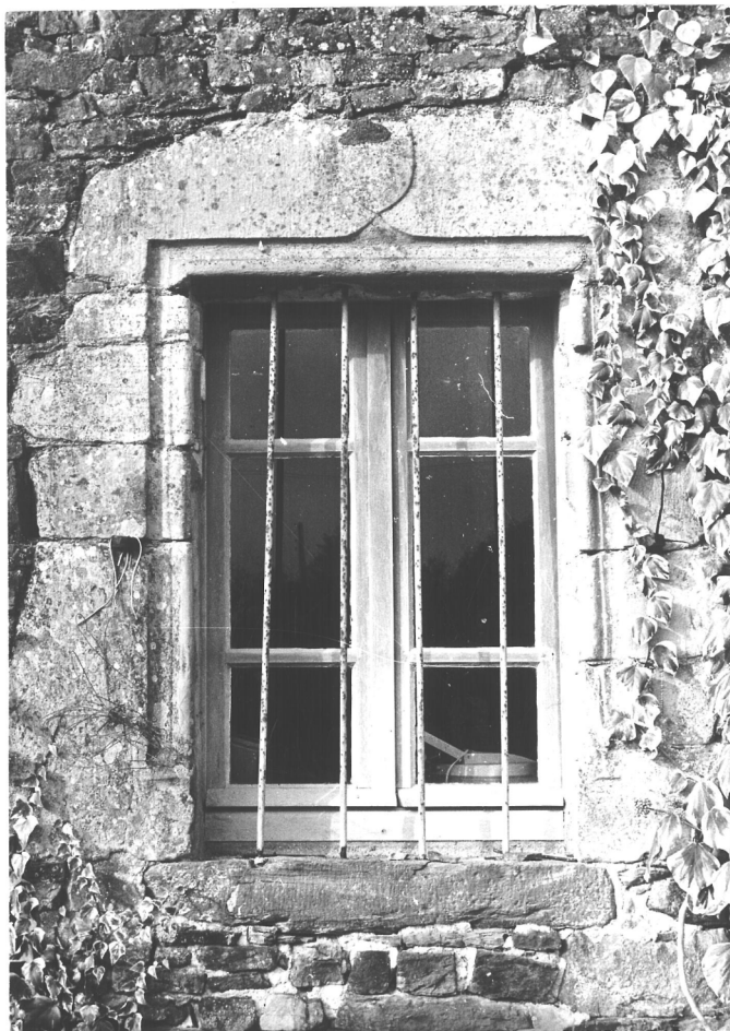
63/30a. Ancien manoir : la façade antérieure porte une trace de reprise (partie gauche) et une trace de collage (partie droite); les encadrements des baies (en partie remaniées) sont, soit en schiste gris bleuté, soit en grès beige.
