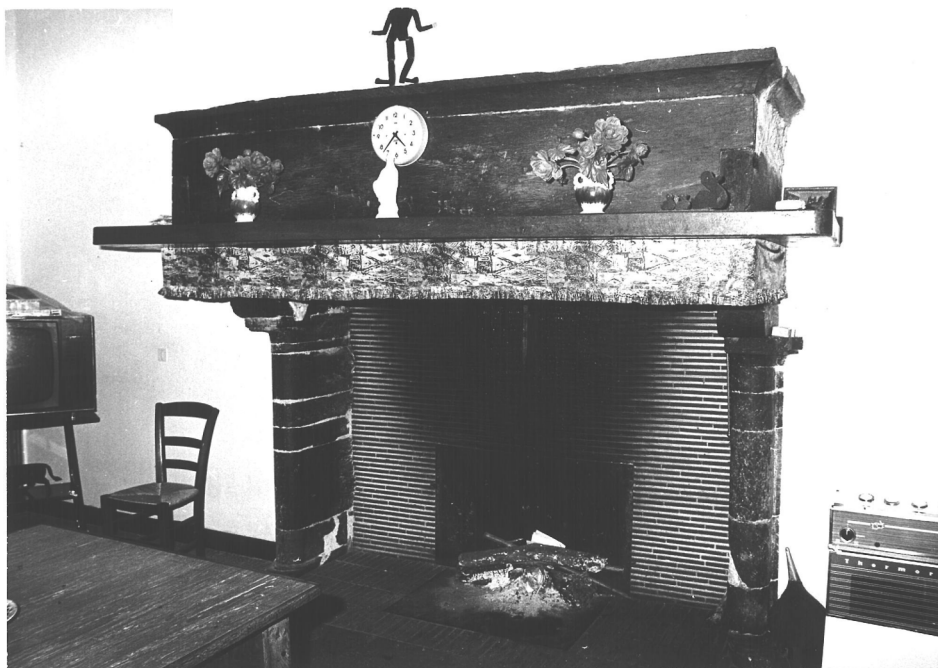
40/9. Cheminée du corps principal, au rez-de-chaussée; entièrement en schiste gris avec consoles galbées et corniche.
