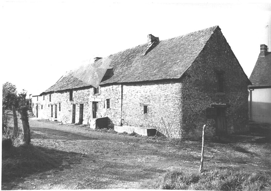
49/24A. Le Puits Couvert. Alignement formé par adjonctions successives (nette trace de collage à droite).
