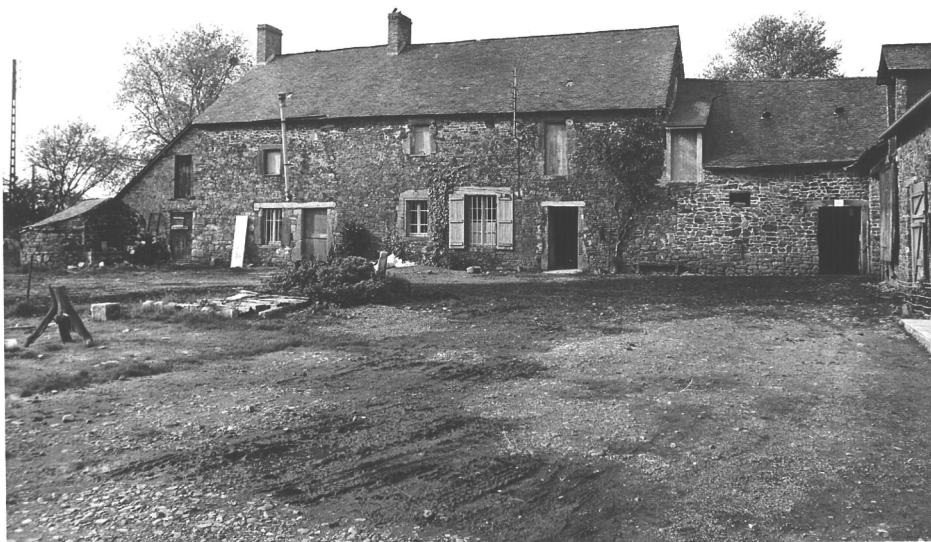
63/30a. Ancien manoir : la façade antérieure porte une trace de reprise (partie gauche) et une trace de collage (partie droite); les encadrements des baies (en partie remaniées) sont, soit en schiste gris bleuté, soit en grès beige.
