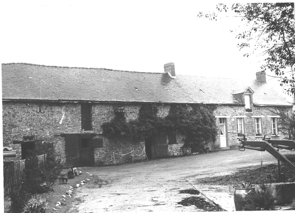
8/0 A. La Cohue. Répartition régulière des ouvertures de même module avec piédroits en briques et linteau en bois
