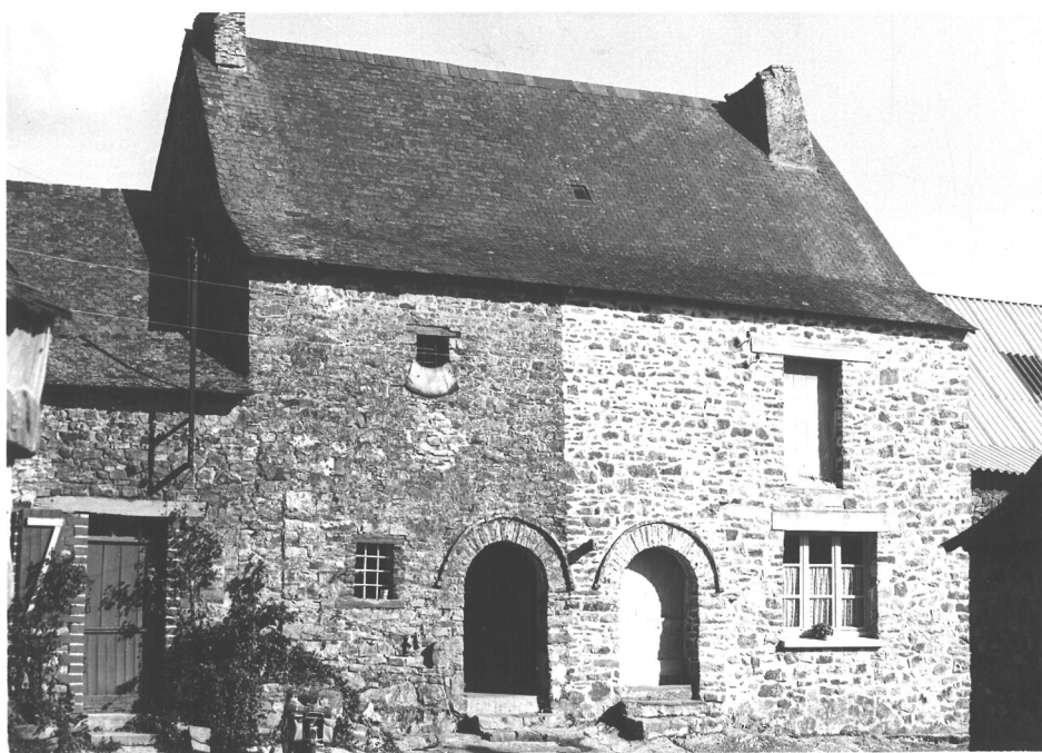
52/3a. Maison du XVIII e siècle à deux logis séparés par un mur de refend; la partie droite a été remontée après éboulement de la façade.
