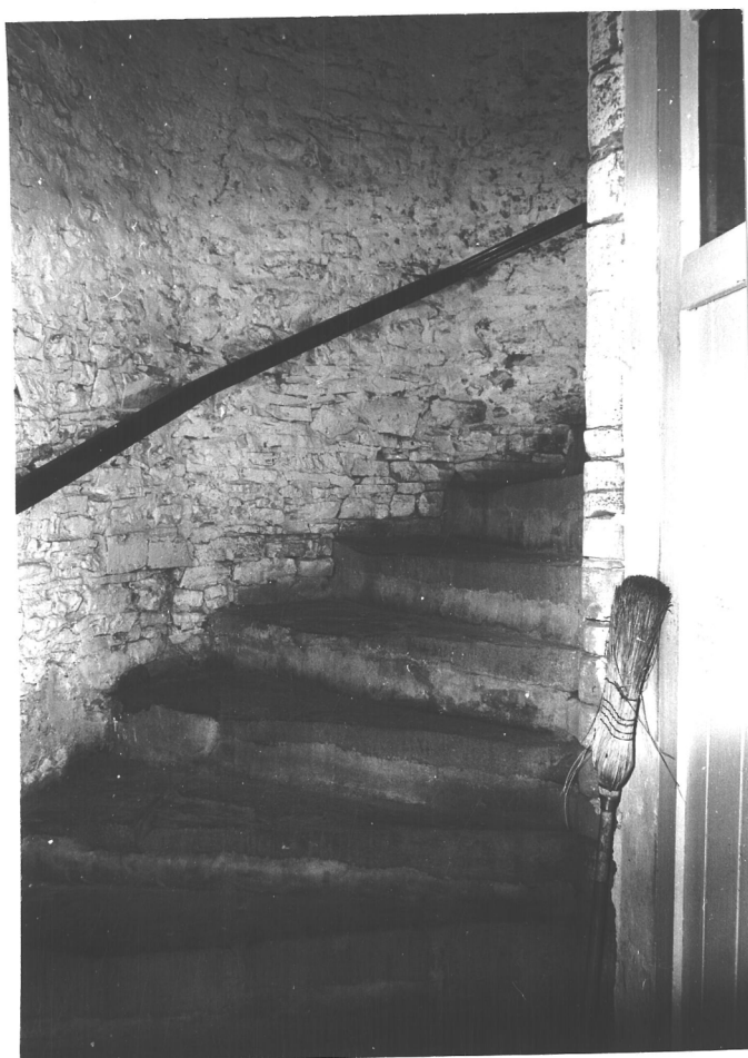
74/17. Détail de cet escalier à vis avec marches en schiste.
