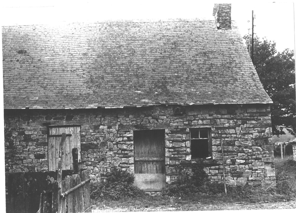
10/14a. La Chauvinière. Partie de la fin du XVIII e siècle, linteaux de bois. Exemple assez rare d'assises alternées de moëllons de grès et de dalles de schiste ardoisier.
