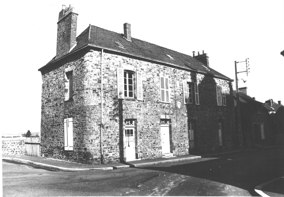
72/6 - Maison n°1 Rue St-Thomas : située au chevet de l'église, elle date du début du XIX e siècle. Élévation ordonnancée en travées à deux niveaux construite en moëllons de schiste et grès.
