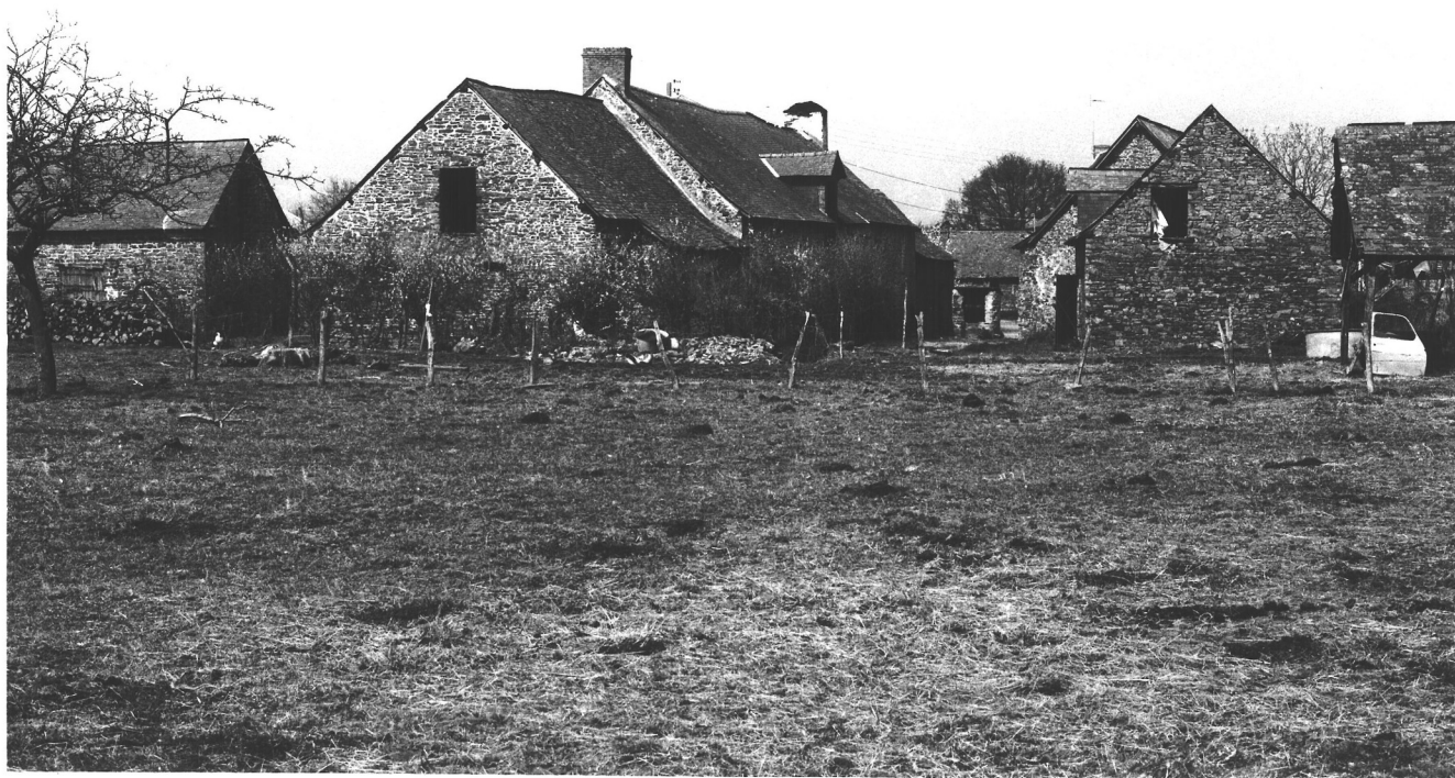
Fig. 2/27 - Vue générale Est.
