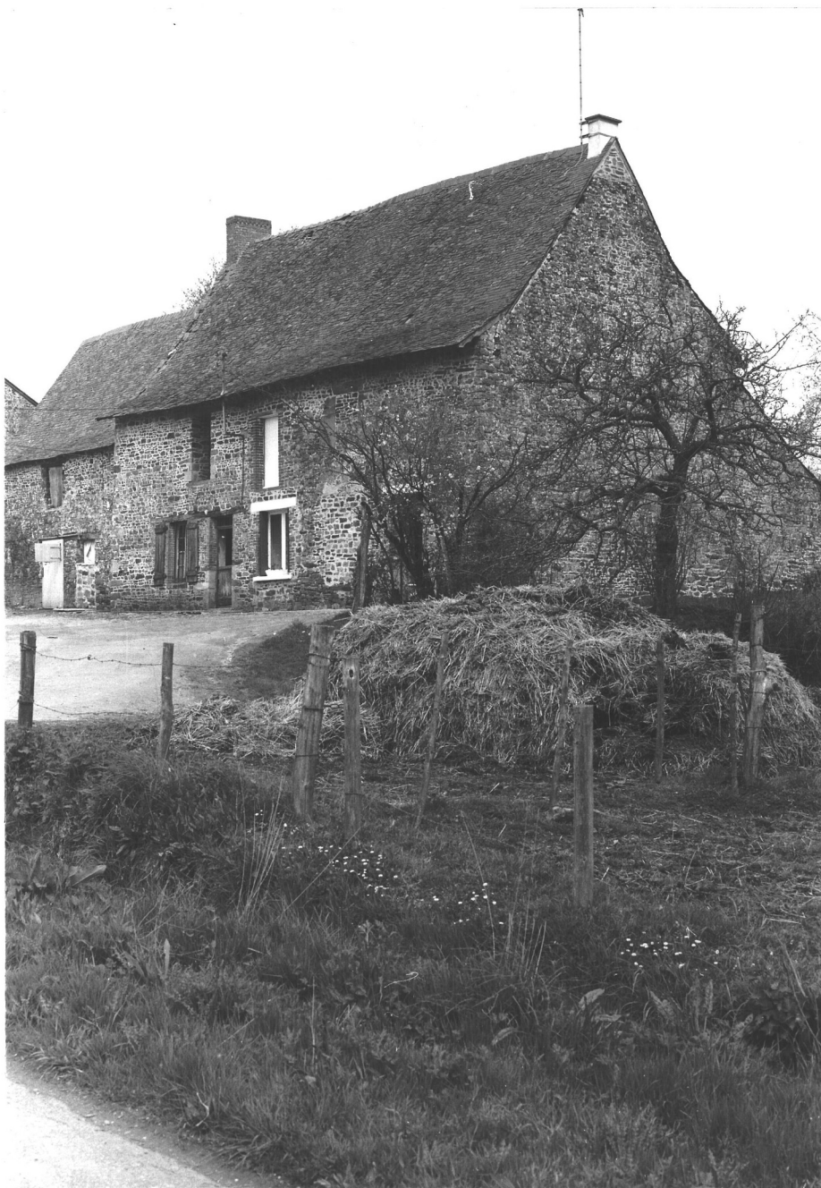
1/25 - Vue générale Sud-Est.
