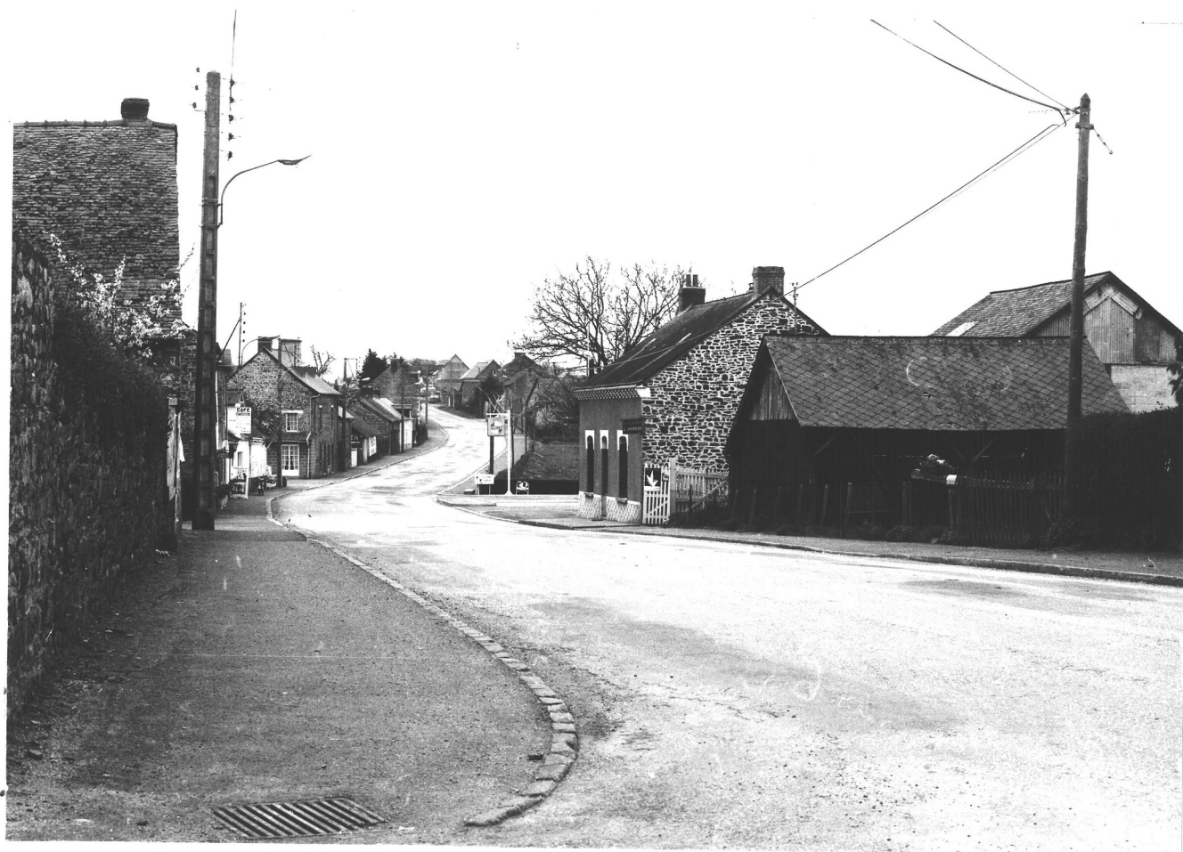
Fig. 2/29 - Vue générale du village, prise vers le Sud, à partir de l'église. Le Village de Forges La Forêt, très peu développé, s'étend sur environ 300 m de part et d'autre de la route Départementale n° 178. L'église est non pas centrale comme il est habituel mais située à la sortie Nord du village. Seule l'église est retenue au titre de l'Inventaire des Monuments.
