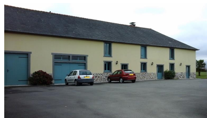
Ferme la Sorinais, 2004. © Région Bretagne
