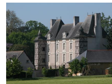
Vue générale nord-est du château de la Glestière, 2004. © Région Bretagne
