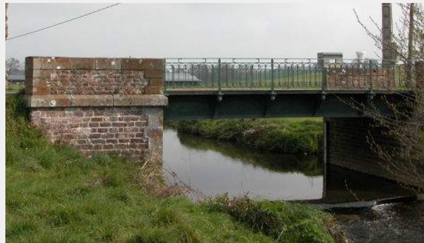
Le pont-routier de Tixue
