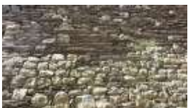
Appareillage mixte irrégulier
