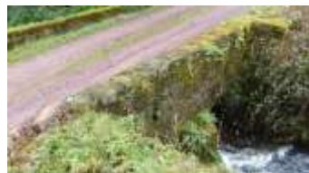
Pont-digue - La Fenderie
