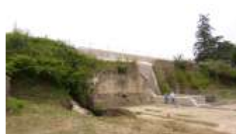
Reste du mécanisme hydraulique
