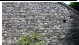
Appareillage moellons de schiste
