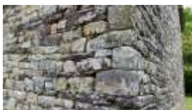
Appareillage et chaîne d'angle régulier
