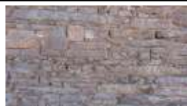
Appareillage irrégulier moellons de schiste
