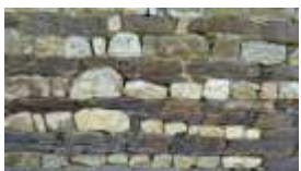
Appareillage mixte irrégulier de moellons
