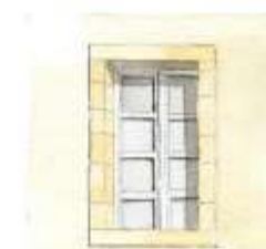
L'encadrement de la fenêtre est en saillie par rapport au reste du mur. Celui-ci était donc destiné à être enduit.
