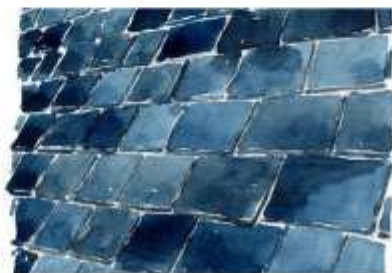
L'ardoise impose une pente minimum.
