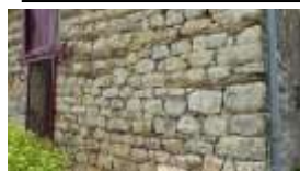
Appareillage moellons de grès
