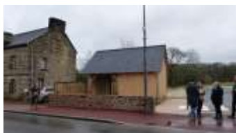
Aménagement d'un nouveau parking avec abri
