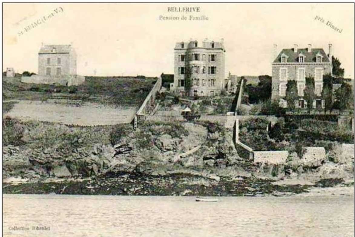
Figure 2 Villa Bellerive, après la construction de l'étage mansardé
