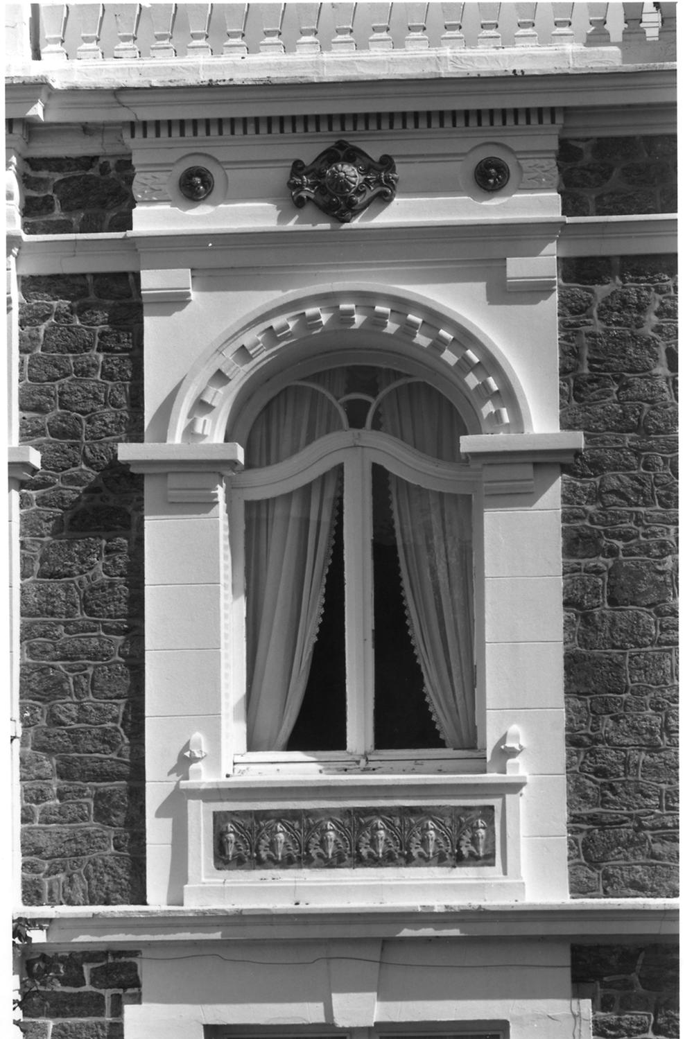
Fig. 5 Détail céramique (façade sur rue) appui de fenêtre de 1<sup>er</sup> étage.
