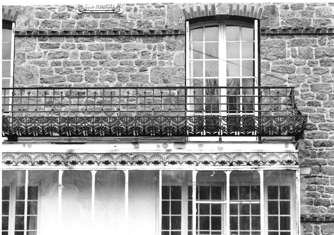
Fig. 4 Façade antérieure, détail : corniche en brique et céramique.
