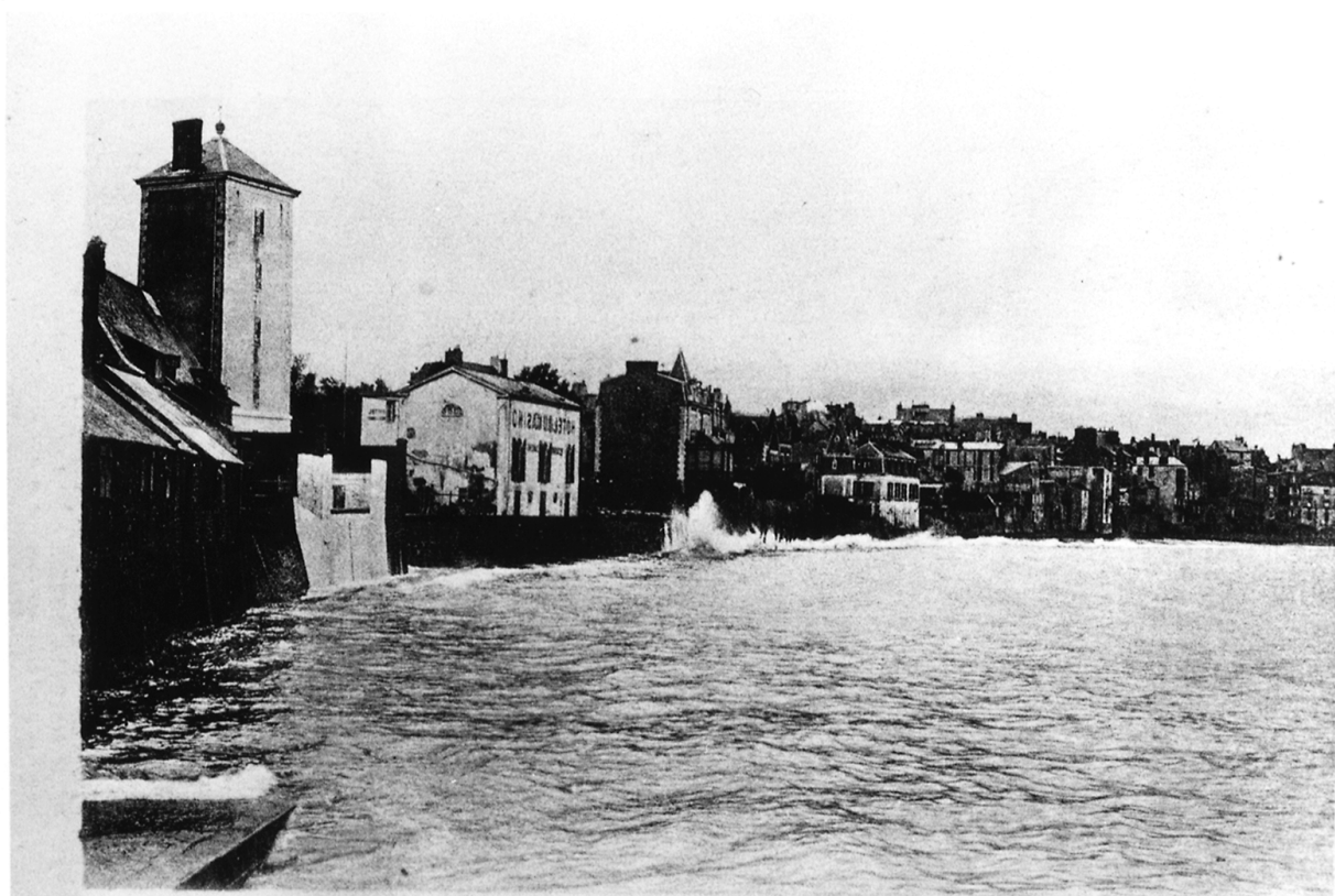
La grosse marée à la pointe du jour devant le Phare et l'Hôtel du Casino des "Bas-Sablons" Big tide at sunrise facing the Light-tower and Casino-Hôtel of the "Bas-Sablons"
