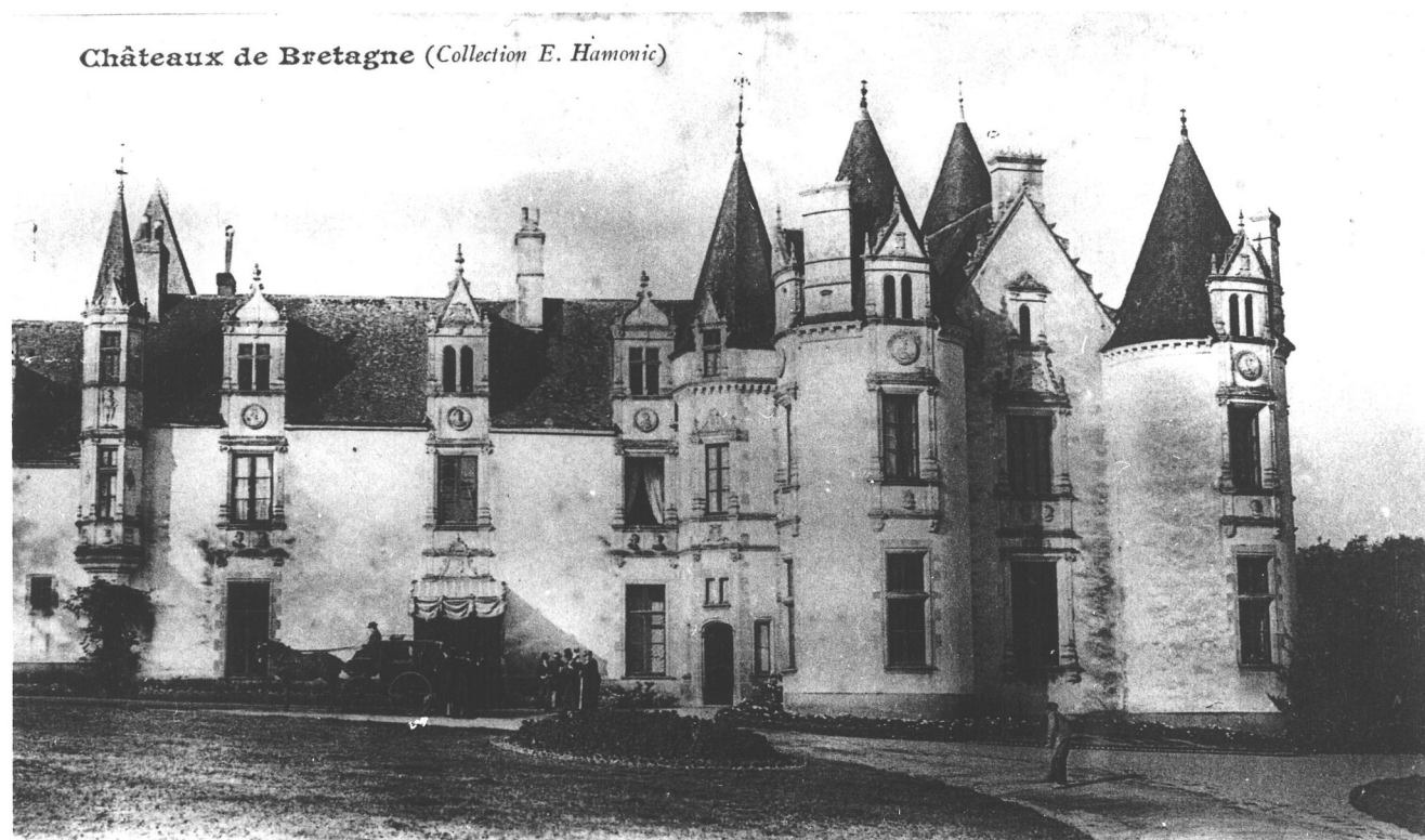
806. - Château des Nétumières-en-Erbrée, près Vitré
