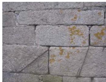
Un appareillage très serré ne nécessitant pas de jointoiement
