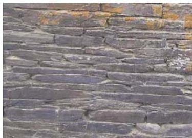
Un appareillage serré nécessitant un léger jointoiement
