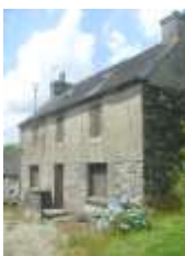
Impact de l'élargissement des ouvertures du rez-de-chaussée
