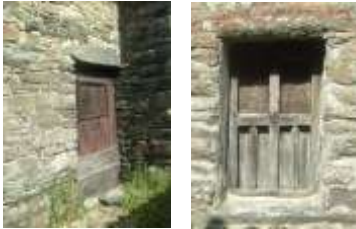
Arc de décharge
