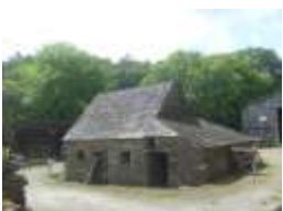
Moulin de Pont Glaz
