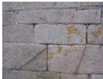
Un appareillage très serré ne nécessitant pas de jointoiment
