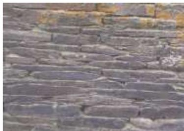
Un appareillage serré nécessitant un léger jointoiment
