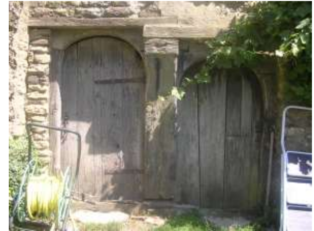
Détail d'une double porte en bois avec le linteau arrondi – Le Bas Trégrit
