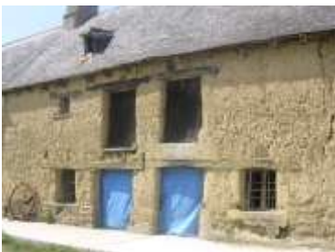
Bâtiment en terre, des ouvertures en carré de bois
