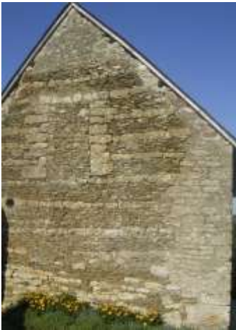
Appareillage soigné en moellons
