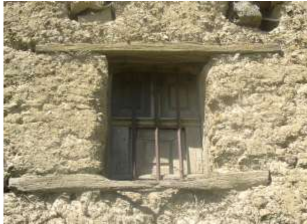
Détails d'ouverture aux jambages en terre, les menuiseries anciennes – le Bas Trégrit
